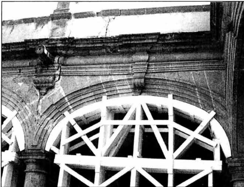
Fig V.11 Arcos dañados
