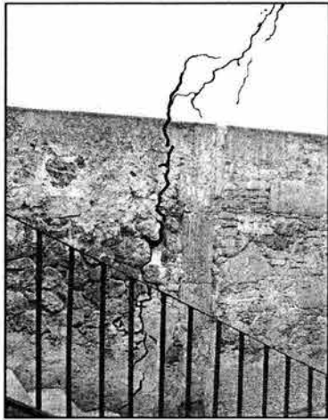
Fig IV.10 Biblioteca (vista por el exterior)
