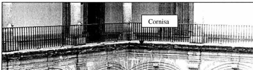
Fig. IV.18 Cornisa del patio principal en el primer nivel
