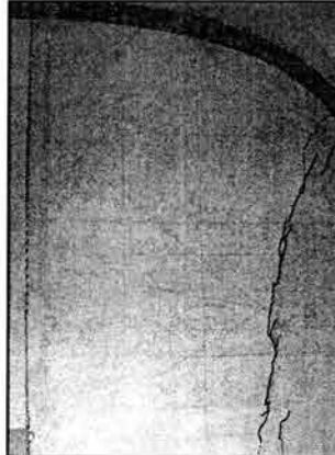
Fig IV.8 Muro de escaleras
