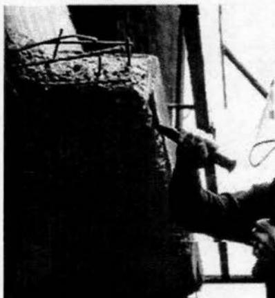
Fig. 4.16.3 Repicado de la superficie y remoción del concreto deteriorado.
