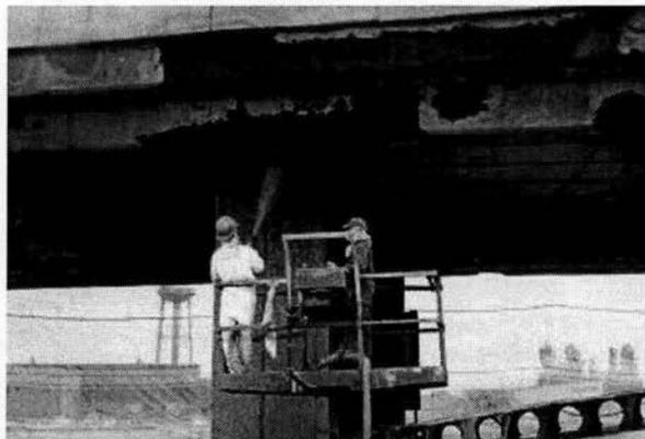
Fig. 4.4.5 Forma correcta de colocación del material de reparación por el método de concreto lanzado
