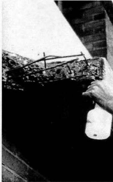
Fig. 4.16.6 Saturación de la superficie con agua.
