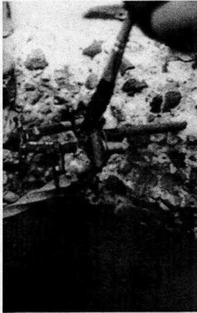
Fig. 4.16.5 Aplicación del *primer* rico en zinc, sobre el acero de refuerzo de la zona a reparar.
