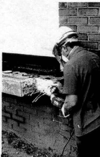
Fig. 4.16.2 Delineación de la región con cortadora de disco.
