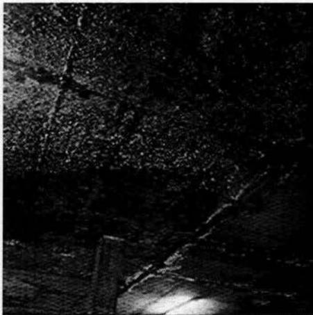
Fig. 4.15.1 Efecto de la acción de congelamiento y descongelamiento en la estructura de un estacionamiento.
