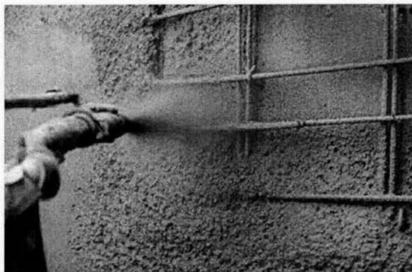
Fig. 4.4.2 El concreto lanzado es un método de colocación efectivo para reparaciones de superficies verticales y elevadas que no contienen refuerzo congestionado.
