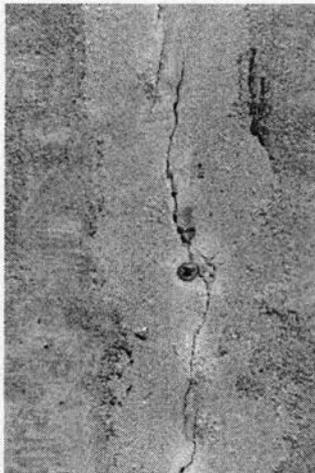
Fig. 4.11.1 Instalación de inyectoros
