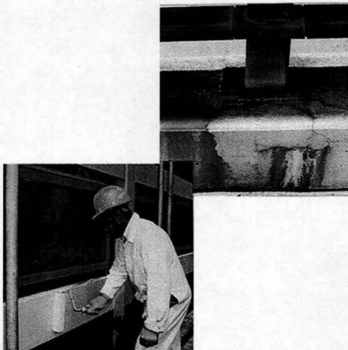
Fig. 4.13.4 Corrosión del acero de refuerzo evidenciada en manchas de óxido en fisuras. Parapeto de concreto en la estructura del parqueadero de un aeropuerto.
