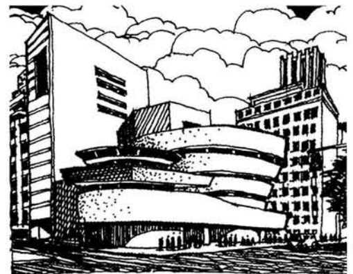
Fig. 127 Forma significativa como sustancia de un lenguaje estructural. Museo Guggenheim, NY, 1959. Frank Lloyd Wright Estructura de bloques de hormigón, Edificio helicoidal.
