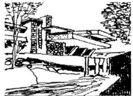
Fig. 69 Frank Lloyd Wright, Casa de la cascada, Bear Run, 1937. Estructura en Cantilever. Hormigón, piedra y hierro
