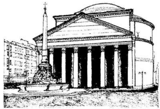
Fig. 190 El panteón de roma 118-128 d.C. estructura que genera poco o nulos esfuerzos de flexión
