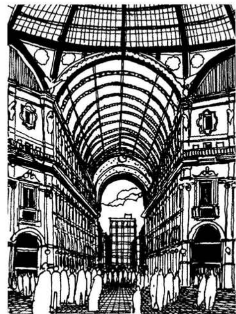
Fig. 109 Estructura con componentes ligeros: arco celular metálico formando una bóveda cubierta de material translúcido y cúpula central de crucero metálico. Galería de Vittorio Emanuele II; Milán, Italia.
