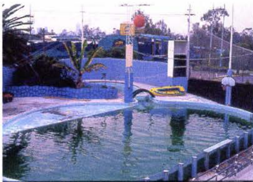
Figura 1. Vista del estanque principal del acuario Atlantis, empresa Convimar, México D., F.
