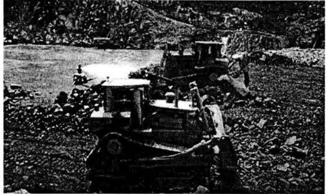
El proceso de relleno en la cortina se ha dividido en etapas de las cuales siempre se busca mantener un tramo avanzado del talud aguas arriba a efecto de que en forma secuencial los concretos en la cara y el plinto puedan ejecutarse lo más pronto posible.
