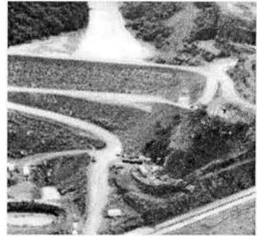
Con el desvío del río se tienen entonces las condiciones de trabajo para iniciar la construcción de la Cortina del P.H. El Cajón.
