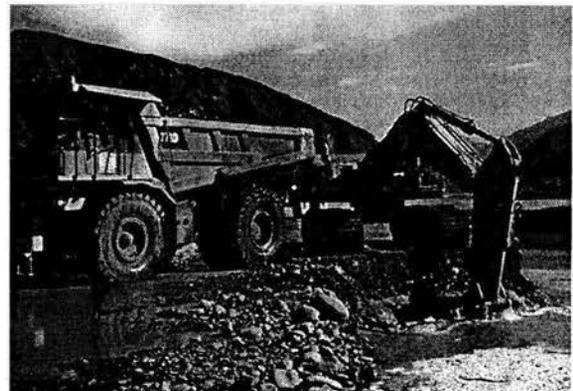
Se iniciará la excavación con retroexcavadora con brazo de largo alcance. Se excavará hasta el total del alcance del brazo de la retroexcavadora que deberá ser de 6 a 8 metros o hasta encontrar roca si ésta aflora a menor profundidad.
