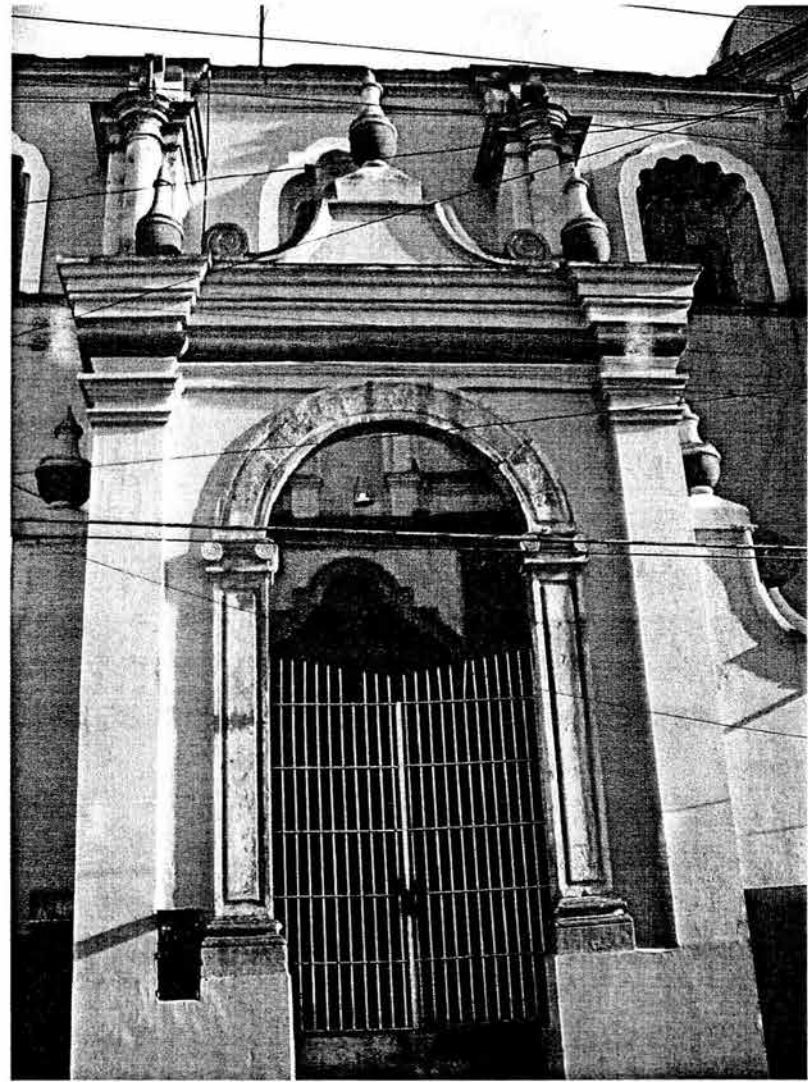
Iglesia de El Carmen acceso lateral
