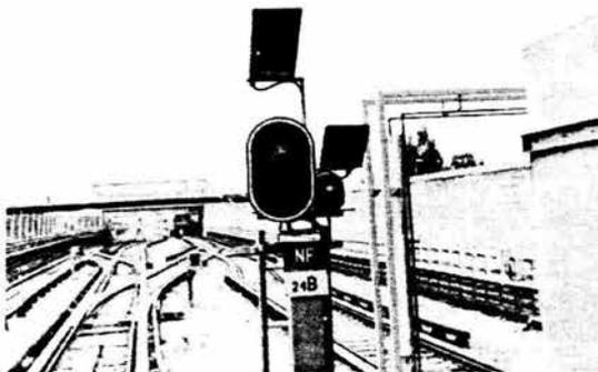
FIG. 3.4 LOS SEMÁFOROS GARANTIZAN UNA DISTANCIA DE SEGURIDAD ENTRE TRENES. S.T.C METRO
