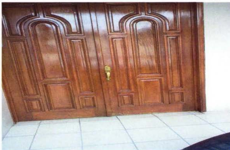
Fotografía 3. Puerta de acceso al interior.
