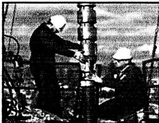
Figura 2.6 Instalación de bomba centrífuga
