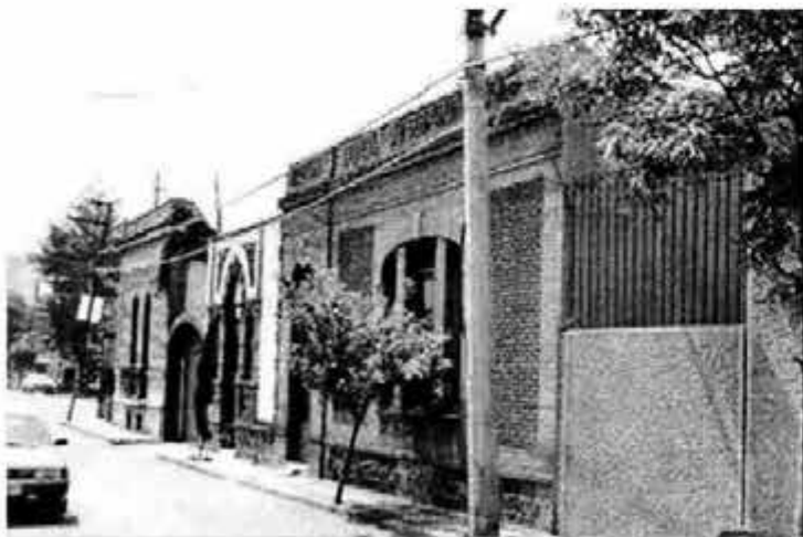
Calle Carracci. Banquetas estrechas, vegetación mal planeada y postes en mal estado.
