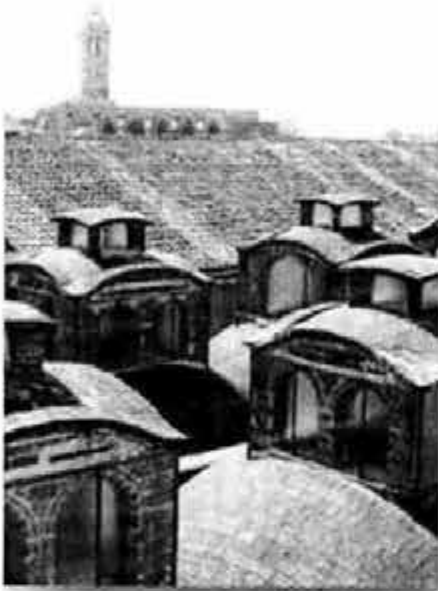
Sala Muncunill. Linternas superpuestas originalmente para ventilación, hoy proporcionan iluminación cenital a la sala.
