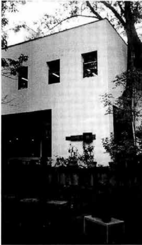
Instituto Mora. Plaza Gómez Farías. Edificio nuevo
