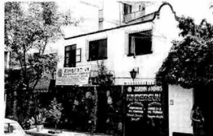
Carracci No. 48. Anuncios pintados en rejas o marfilas. Mucho cableado mal distribuido.
