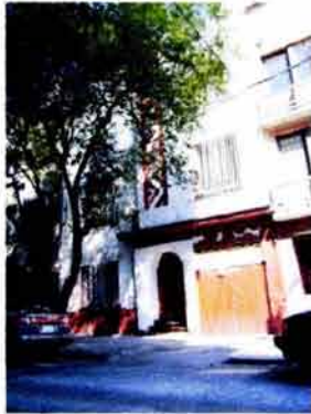
Edificio Chilpancingo Chilpancingo No. 8 Col. Hipódromo Condesa Foto 109
