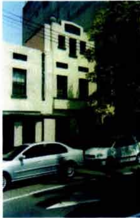
Edificio de departamentos Nuevo León No. 11 Col. Hipódromo Condesa Foto 136
