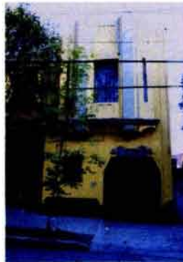
Casa habitación Av. Amsterdam No. 235 Col. Hipódromo condesa. Foto 85
