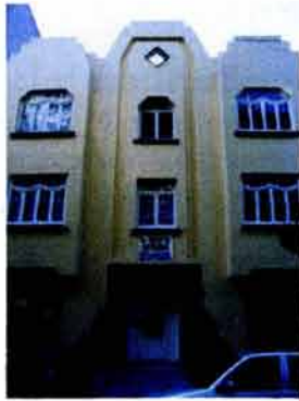
Casa habitación Av. Amsterdam No. 248 Col. Hipódromo condesa. Foto 84
