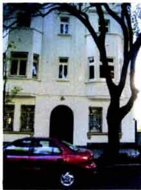
Casa Habitación E y R Cadena, 1929 Av. Amsterdam No. 266 Col. Hipódromo Condesa Foto 87
