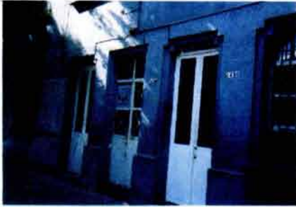
Despacho y oficinas C/Campeche No. 143 A,B,C Col. Roma Oriente Foto 92
