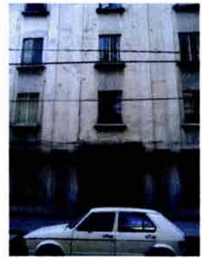
Casa Habitación Av. Amsterdam No. 131 Col. Hipódromo Condesa Foto 120
