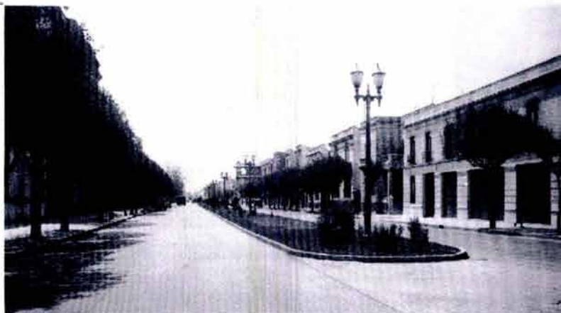
Aspecto que tenía la Avenida Veracruz, hoy Insurgentes, a la altura de la calle de Durango en la década de los años veinte.
