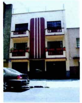
Edificio de departamentos C/ Pachuca No. 78 Col. Condesa Foto 138
