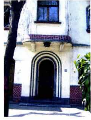
Casa Habitación Av. México No 63 Col. Hipódromo Condesa Foto 72
