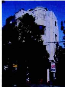
Edificio Amsterdam Av. Amsterdam No. 154 Col. Hipódromo Condesa Foto 163
