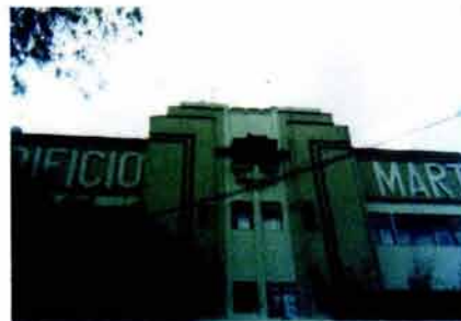
Edificio Marti C/ Sindicalismo No. 87 Col. Condesa. Foto 140
