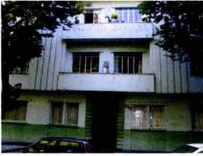
Edificio Departamentos Av. Amsterdam No. 252 Col. Hipódromo Condesa Foto 118
