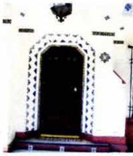
Casa Habitación Av. México No. 25 Col. Hipódromo Condesa Foto 68
