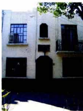
Casa Habitación Av. México No. 198-A Col. Hipódromo Condesa Foto 76
