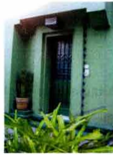
Casa Habitación Av. Amsterdam No. 323 Col. Hipódromo Condesa Foto 69
