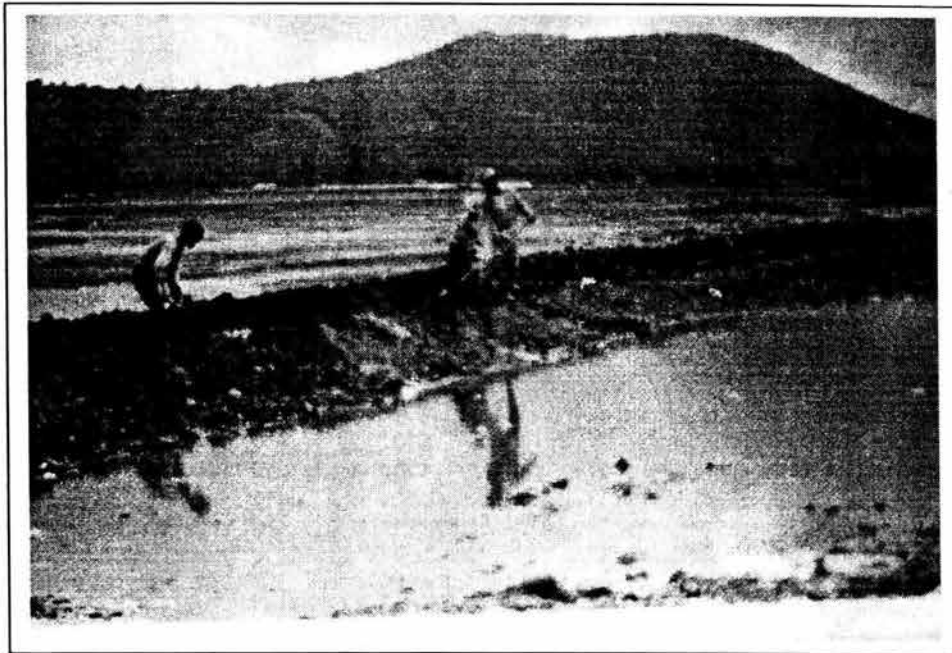
Ejecución de trabajos de rehabilitación de cepas para líneas de conducción de agua y drenaje, s/f. Archivo fotográfico del Centro de Información y Documentación de Nezahualcóyotl (C.I.D.NE.)
