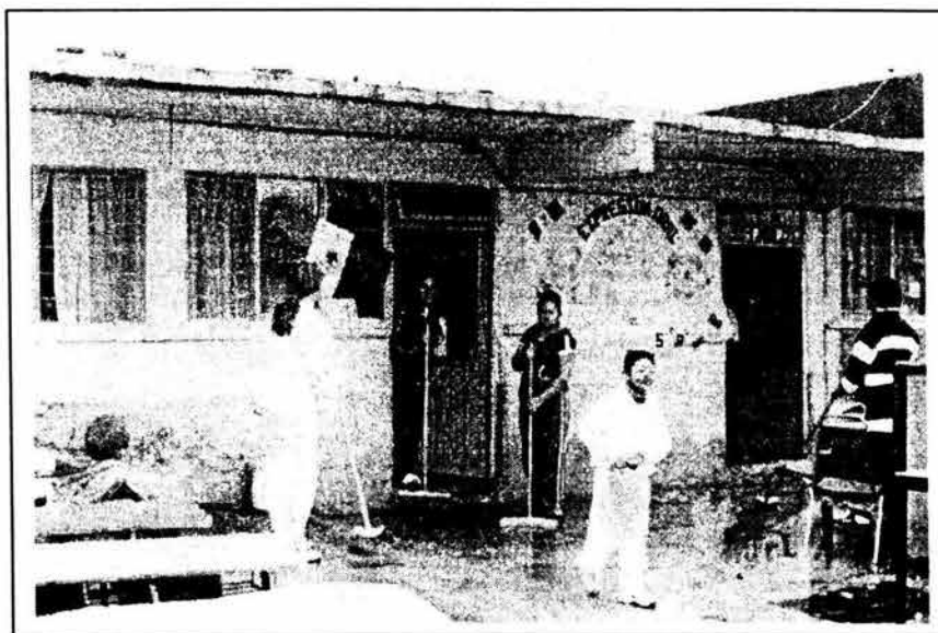
Inundación en una escuela primaria de la V zona, 2002 Recorrido de observación en Ecatepec de Morelos.
