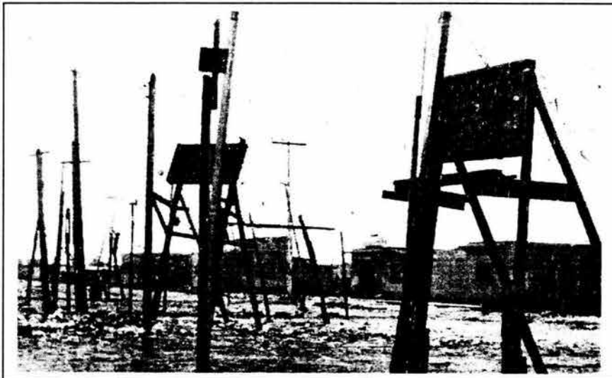
"Telarañas" Cableado provisional de luz en el municipio de Nezahualcóyotl, 1973. Archivo fotográfico C.I.D.NE
