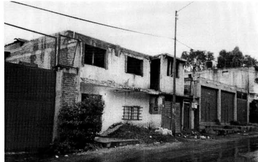
La gran mayoría de las construcciones de la zona son producto de la autoconstrucción.
