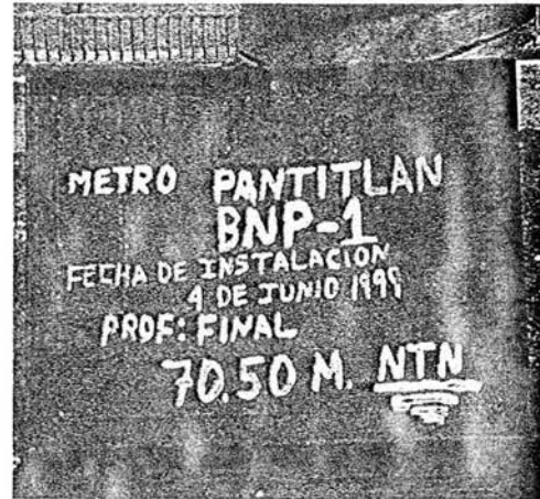
fig. 1.7 tapa de la caja del Banco de Nivel Profundo
