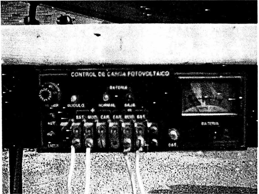
Fig.3.8. Control de carga fotovoltaico
