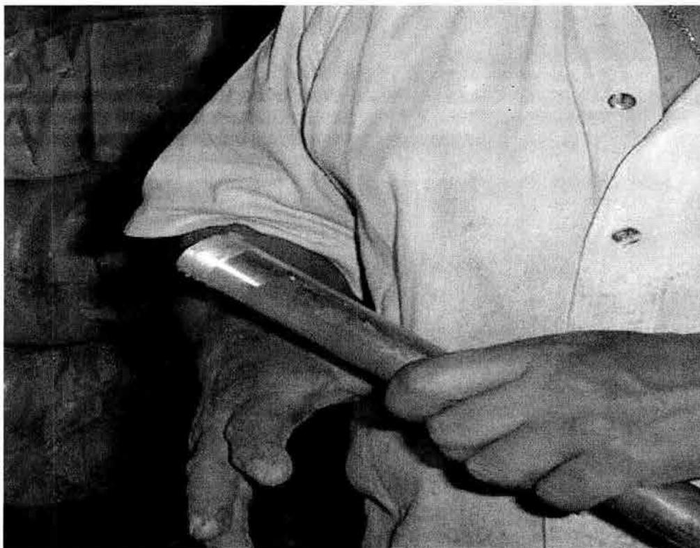
**APLICACIÓN DE LA PASTA FUNDENTE EN EL EXTREMO DE LA TUBERIA PREVIO A LA APLICACIÓN DE LA SOLDADURA Y EN LA CONEXION.**
