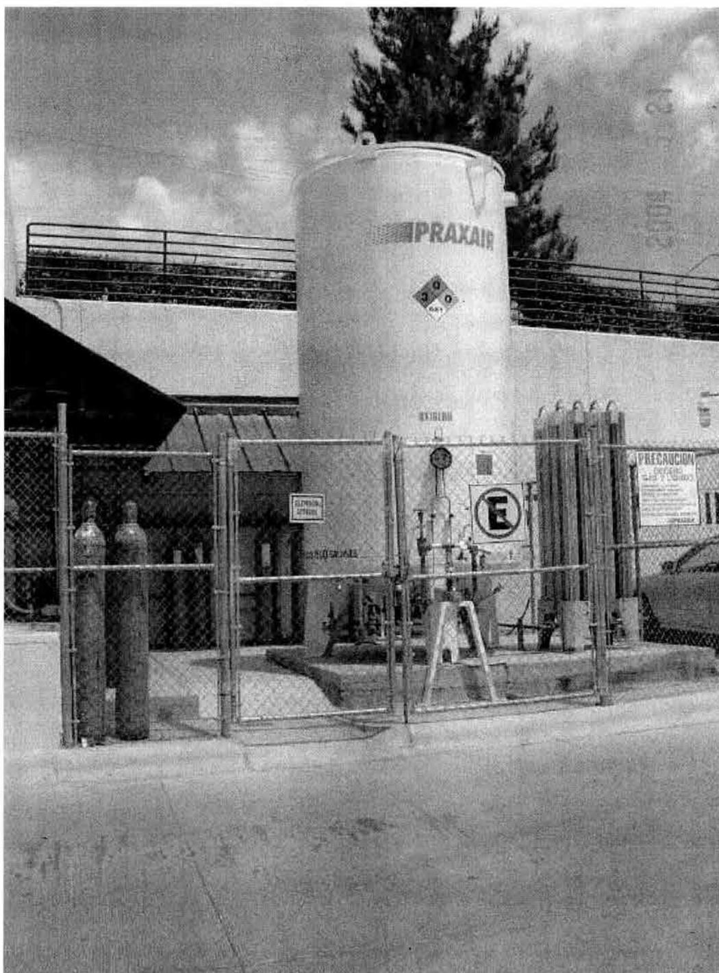
**A LA FECHA DE ELABORACION DE ESTE TRABAJO NO SE TIENE CONSTRUIDO EL AREA DE TANQUE TERMO. SE ANEXA ESTA IMAGEN DE UN HOSPITAL SIMILAR EN EL QUE SE MUESTRA EL TANQUE PRINCIPAL Y LOS DE RESPLADO.**
