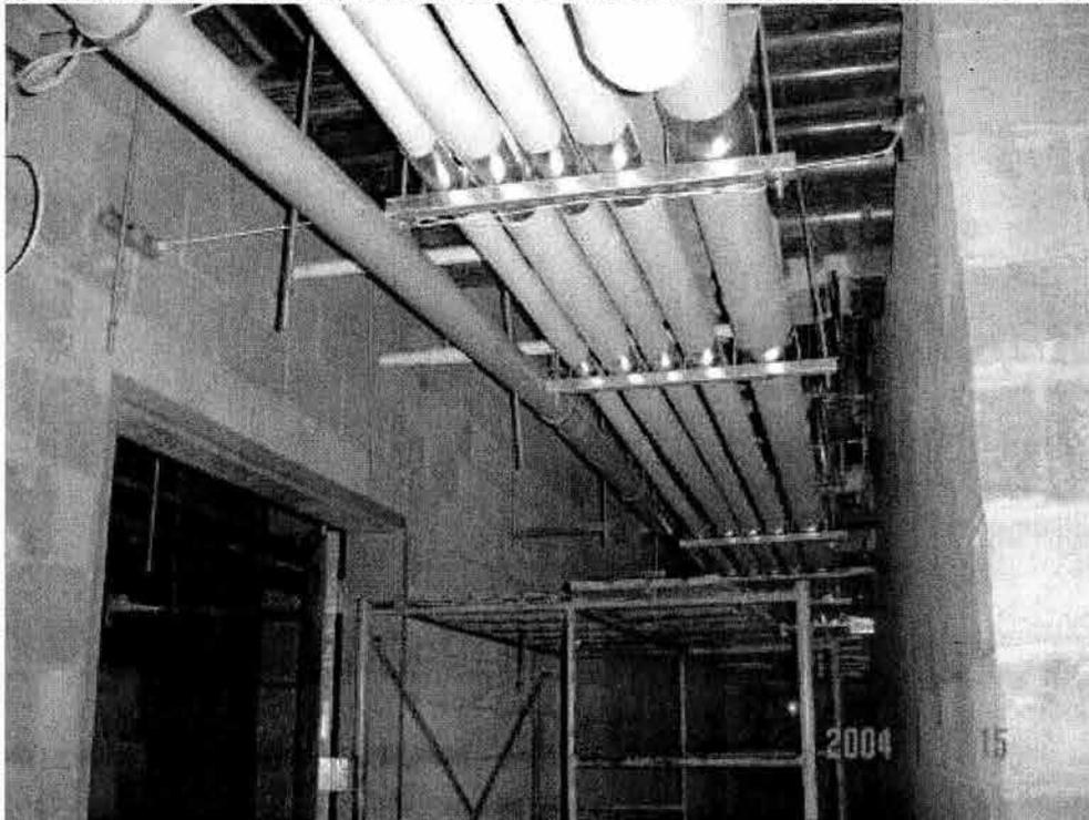
**INSTALACION DEL AISLAMIENTO EN LA TUBERIA DE COBRE DE AGUA CALIENTE**
