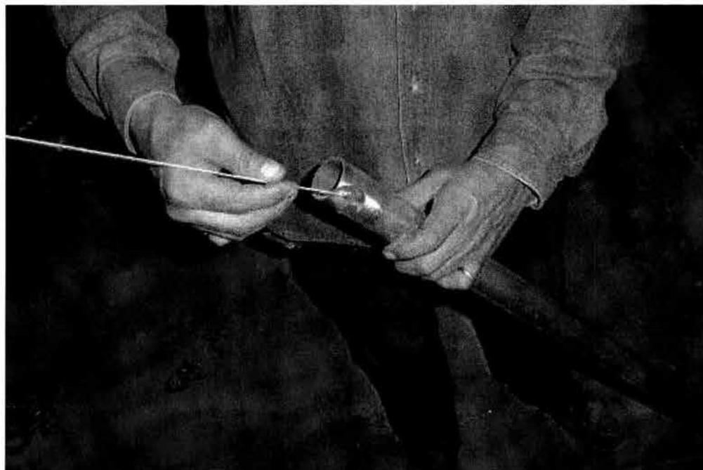
**APLICACIÓN DE LA PASTA FUNDENTE EN EL EXTREMO DE LA TUBERIA PREVIO A LA APLICACIÓN DE LA SOLDADURA Y EN LA CONEXION.**
