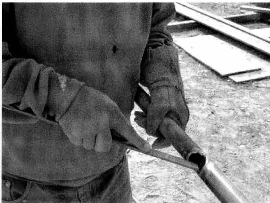
**DESBASTE DEL AREA CORTADA PARA REALIZAR LA CONEXIÓN SOLDADA.**
