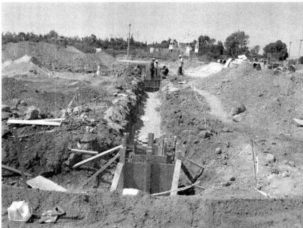
**EN ESTA IMAGEN SE OBSERVAN LAS ZANJAS CON SU CAMA DE ARENA Y LA CONSTRUCCION DE LOS REGISTROS DE CONCRETO.**
