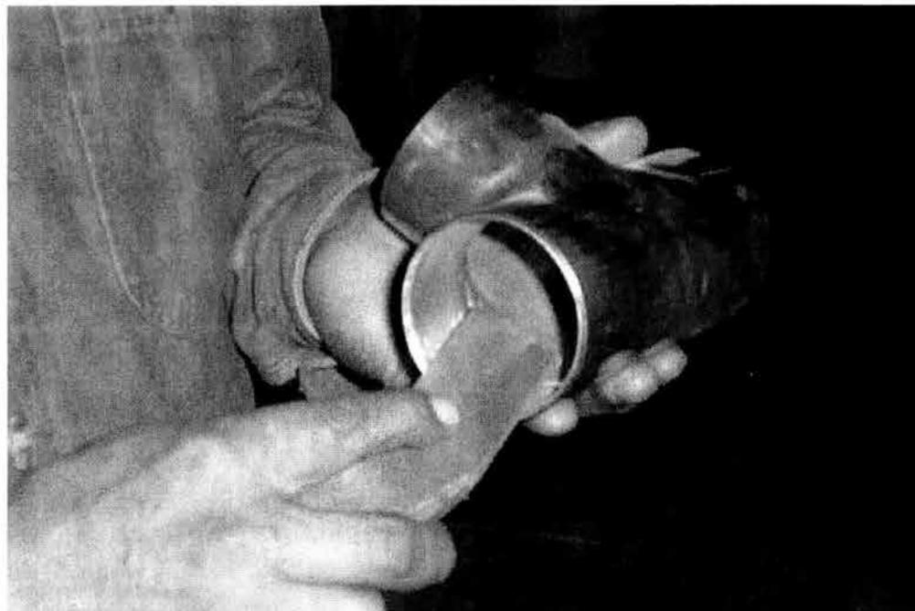
**LIJADO DE EXTREMOS DE LA TUBERIA Y DEL INTERIOR DE LAS CONEXIONES A SOLDAR.**
