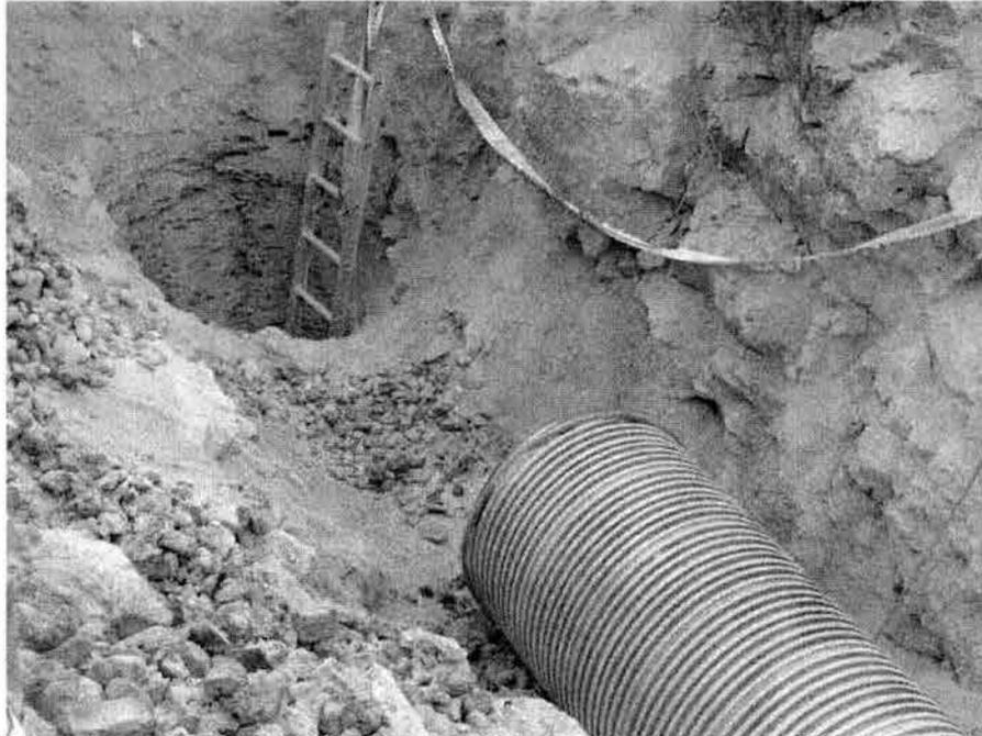
**PERFORACION REALIZADA PARA LA CONSTRUCCION DE POZOS DE ABSORCION DE LAS AGUAS PLUVIALES QUE SE RECOLECTARAN EN EL ESTACIONAMIENTO**
