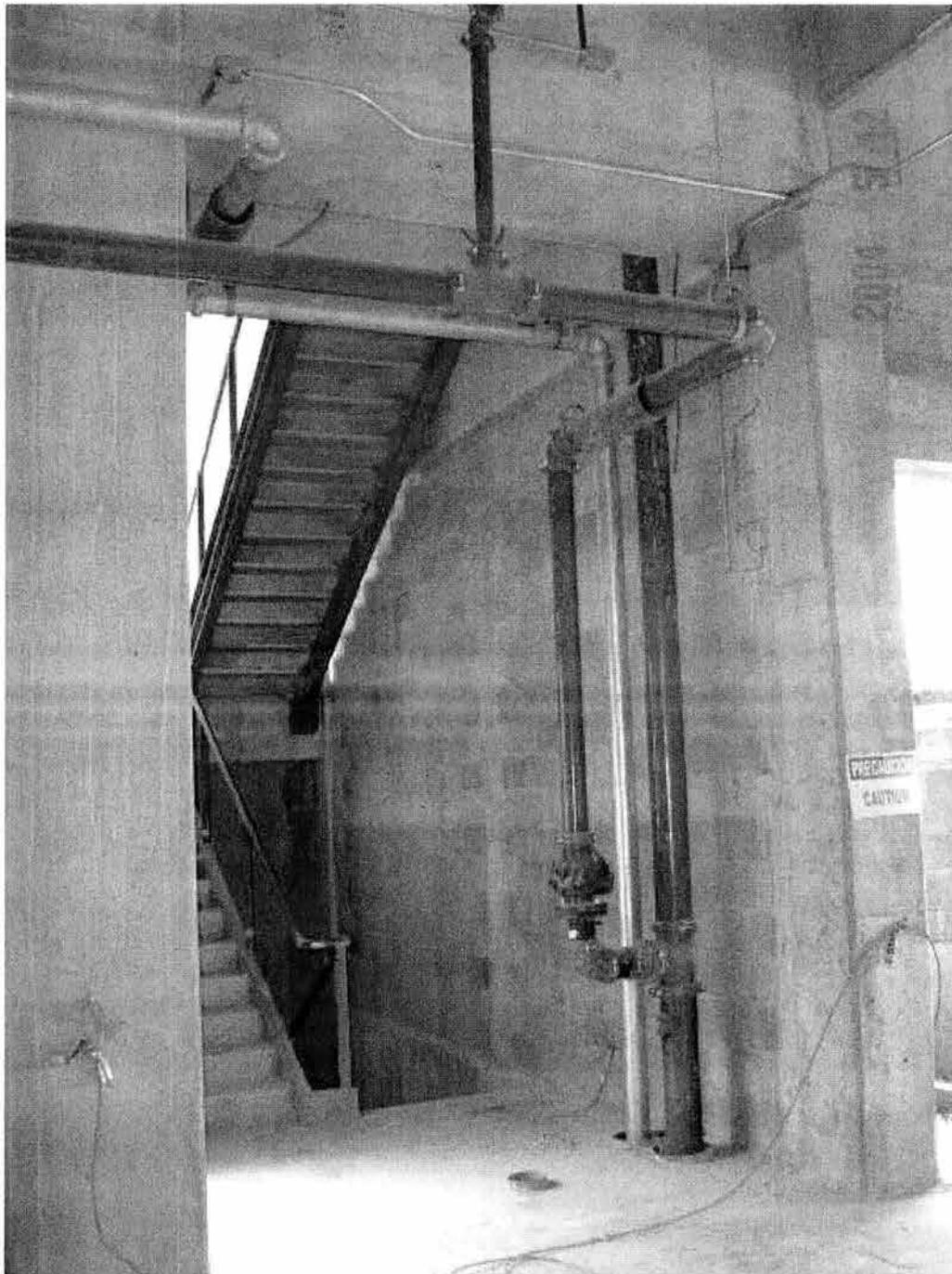
**EN ESTA IMAGEN SE OBSERVA EL RAISER O COLUMNA DE ALIMENTACION AL SISTEMA, Y DEL CUAL SE DERIVA UNA ALIMENTACION SECUNDARIA AL SEGUNDO NIVEL. EN EL INICIO DE ESTA ALIMENTACION SE COLOCA UNA VALVULA DE CONTROL Y SECCIONAMIENTO.**
