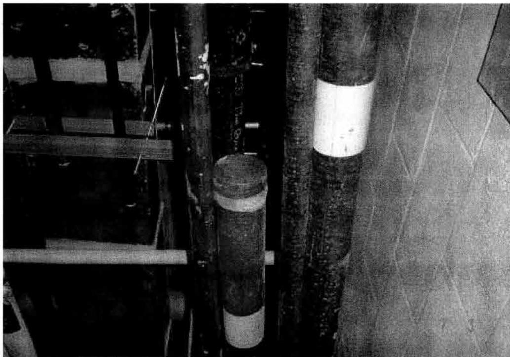
**EN ESTA IMAGEN SE OBSERVA EL CUIDADO QUE SE DEBE TENER CON LAS TUBERIAS DE GASES MEDICINALES, ESTA TUBERIA DEBE SER COMPRADA, MANEJADA Y COLOCADA SIEMPRE CON TAPONES A LOS EXTREMOS PARA EVITAR LA CONTAMINACION DE LOS TUBOS.**
