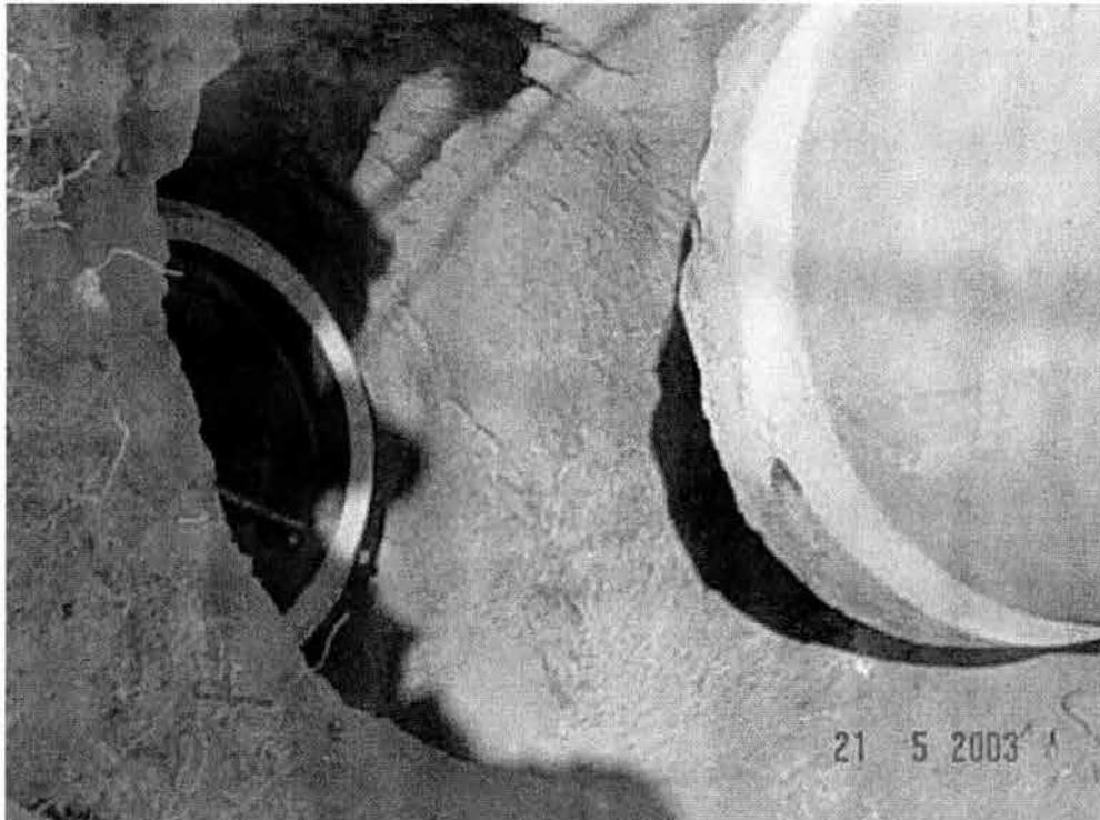
**INCADO DE TUBERIA DE CONCRETO EN LOS POZOS DE ABSORCION. SE PODRA OBSERVAR QUE NO TIENE PERFORACIONES ESTA TUBERÍA. DEBIDO A QUE ES LA TUBERIA SUPERIOR DEL POZO.**
