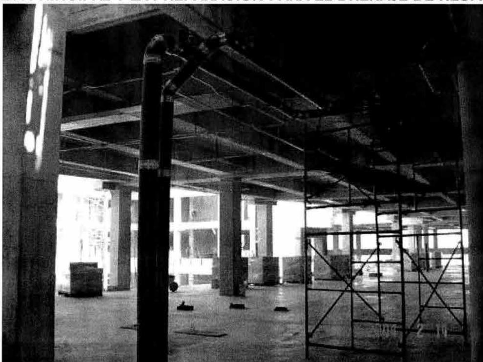
**VISTA GENERAL DE BAJADAS DE AGUA PLUVIAL, SE PUEDE OBSERVAR LA BAJADA PRINCIPAL Y EL DRENAJE DE RESPALDO.**
