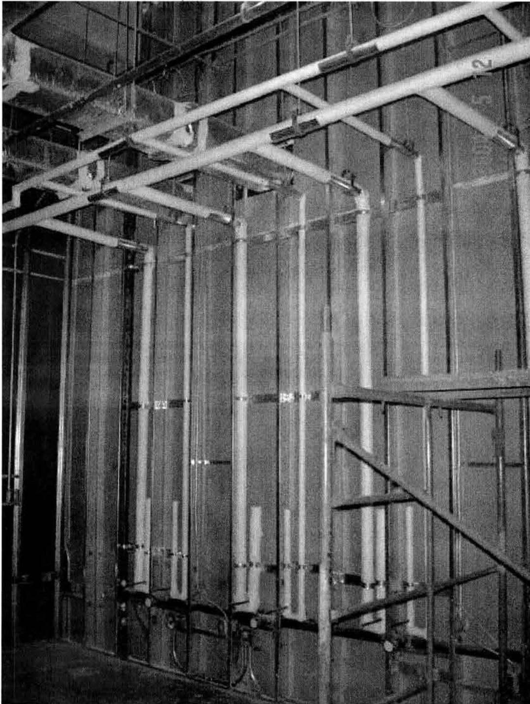
**EN ESTA FOTOGRAFIA PODEMOS OBSERVAR LA COLOCACION DE AISLAMIENTO TANTO EN TUBERIAS DE AGUA FRIA COMO DE AGUA CALIENTE, SE PUEDE OBSERVAR QUE EL AISLAMIENTO DE AGUA CALIENTE ES DE MUCHO MAYOR DIAMETRO. COMO DATO ADICIONAL, SE OBSERVA QUE LA CAMARA DE AIRE PARA EL GOLPE DE ARIETE TAMBIÉN ES AISLADO.**
