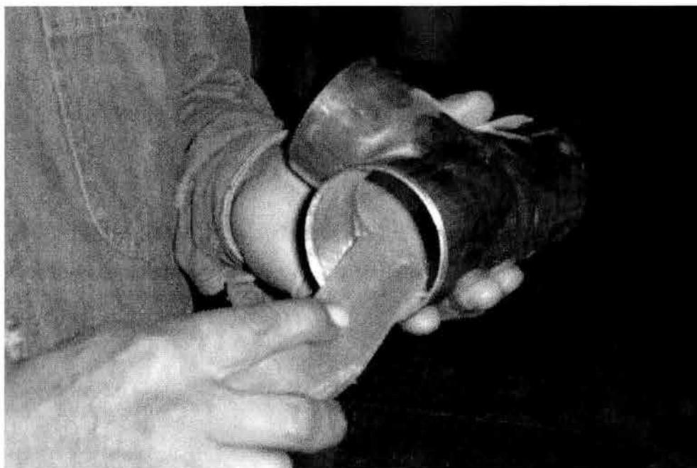
**PREPARACION DE LOS ACCESORIOS DE COBRE RIGIDO, PARA UNIRLOS CON LA TUBERIA. SE REALIZA LA LIMPIEZA Y LIJADO, PARA APLICAR EL FUNDENTE.**
