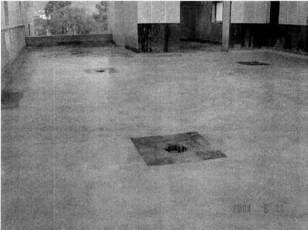
**VISTA GENERAL DE AZOTEA EN LA QUE SE OBSERVAN LAS DIFERENTES BAJADAS PLUVIALES DE UNA TERRAZA DE SERVICIO.**
