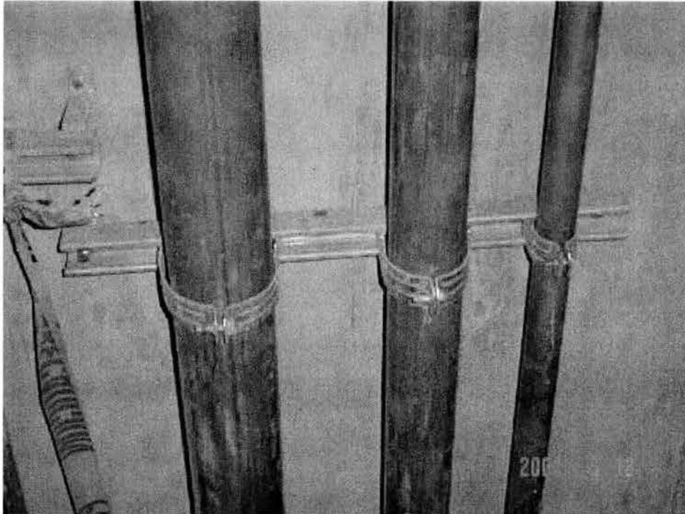
**DETALLE DE SOPORTERIA EN COLUMNAS DE AGUA FRIA**
