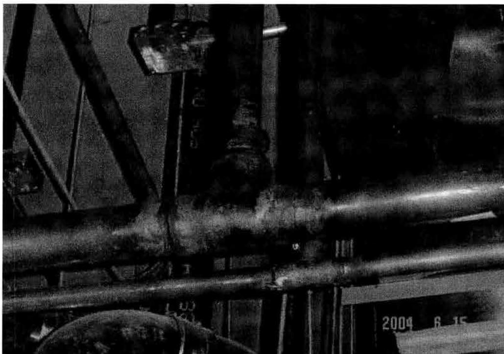
**ACERCAMIENTO DE CONEXIONES SOLDADAS. SE OBSERVA EL COLOR CARACTERISTICO DE LA SOLDADURA ESPECIAL (FUERTE)**
