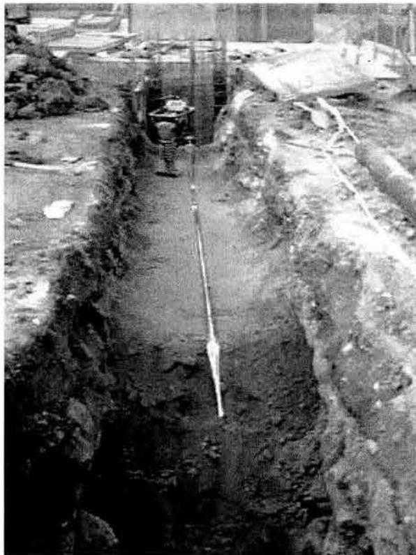
**EN ESTA IMAGEN SE OBSERVA LA TRINCHERA DE TUBERIA SUBTERRANEA, SE OBSERVA LA COLOCACION DE CINTA METALICA PARA SU IDENTIFICACION.**
