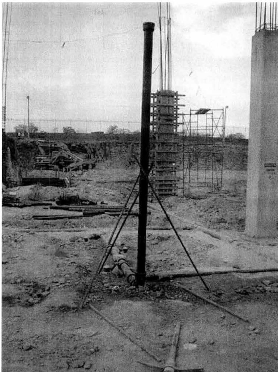
**EN ESTA IMAGEN SE PUEDE VER LAS INSTALACIONES SANITARIAS SUBTERRANEAS EN PROCESO DE PRUEBA. EL TUBO VERTICAL ES LA COLUMNA DE AGUA A 3 METROS.**
