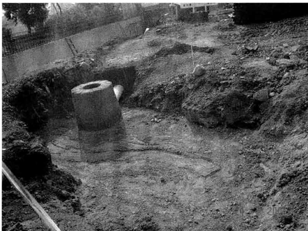
**CONSTRUCCION DE REGISTRO, RELLENO Y TERMINACION DEL POZO DE ABSORCION, SE PUEDE VER LA LLEGADA DEL TUBO DE DRENAJE DE PVC EN EL AREA DE ESTACIONAMIENTO**
