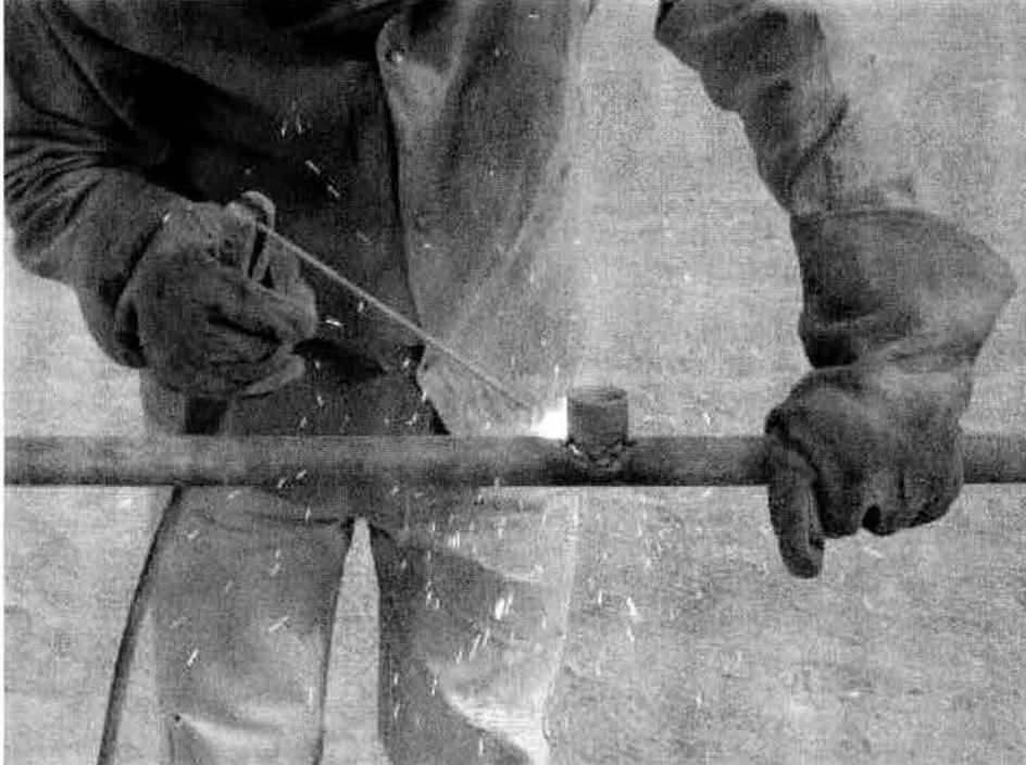
**APLICACIÓN DE SOLDADURA EN LAS PIEZAS DE LAS DERIVACIONES A ROCIADORES.**
