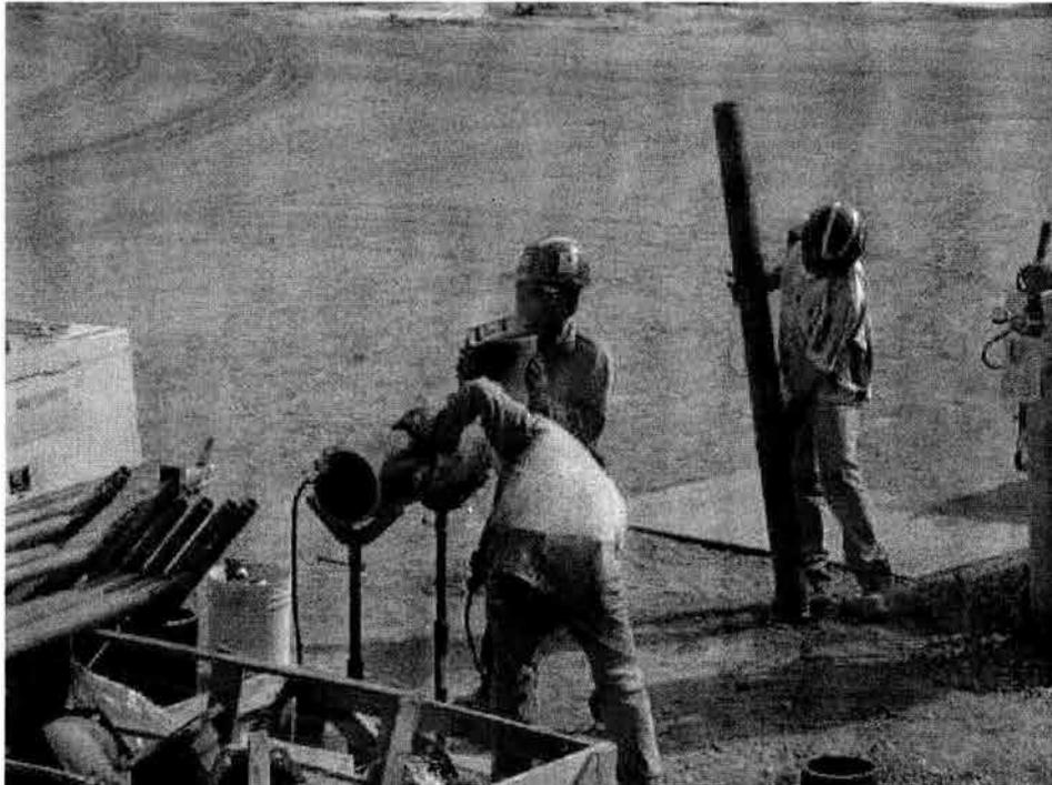
**EN ESTAIMAGEN SE OBSERBA EL HABILITADO Y PREARMADO DE UN TUBO Y UN CODO SOLDABLE. LA TUBERIA DEBE ESTAR A NIVEL.**
