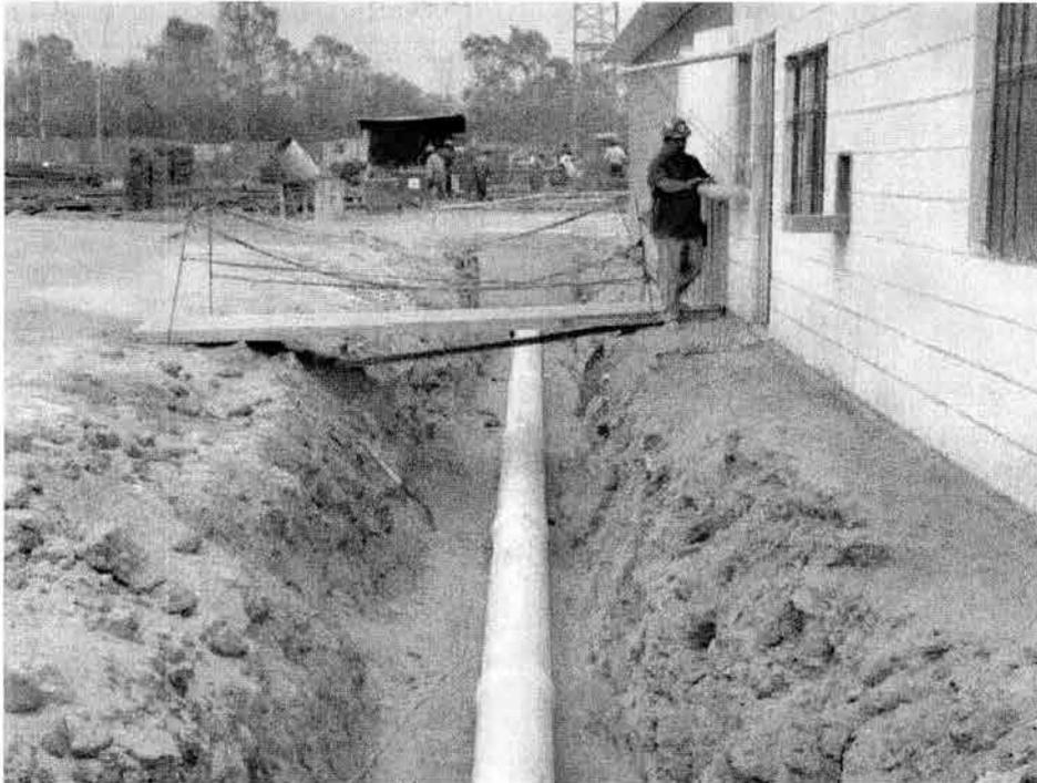
**INSTALACION DE TUBERÍA DE PVC CON CAMPANA EN AREA DE ESTACIONAMIENTO. AL FINAL SE PUEDE VER UN REGISTRO DE CONCRETO CON REJILLA PARA COLECCIÓN DE AGUA PLUVIAL.**
