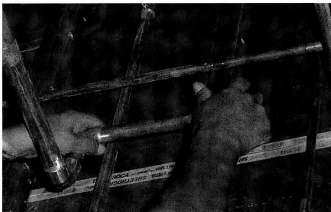
**PRE ARMADO DE LA TUBERIA PARA SU VERIFICACION EN LA POSICION DEFINITIVA, PREVIO A LA APLICACIÓN DE LA SOLDADURA.**
