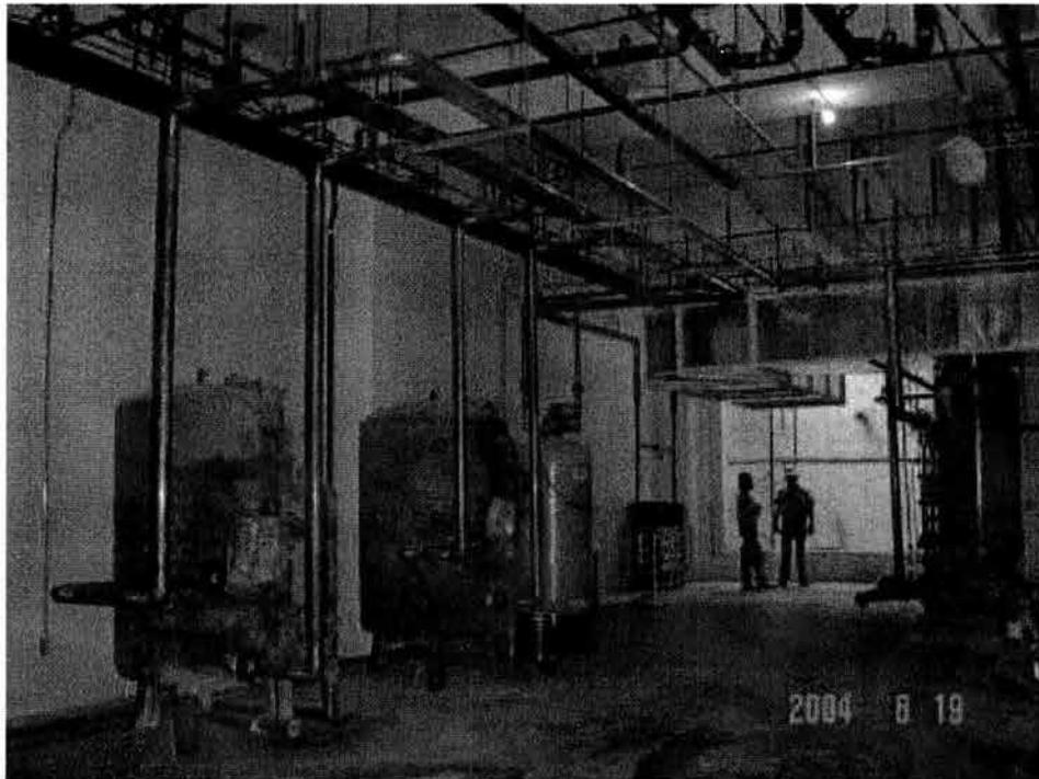
**EN ESTA IMAGEN SE OBSERVA EL AVANCE EN LA CONEXIÓN DE LOS EQUIPOS DE FILTRADO JUNTO AL FILTRO DE LECHO PROFUNDO SE OBSERVA EL TANQUE SUAVIZADOR. Y AL FONDO EL GERMICIDA ULTRAVIOLETA.**
