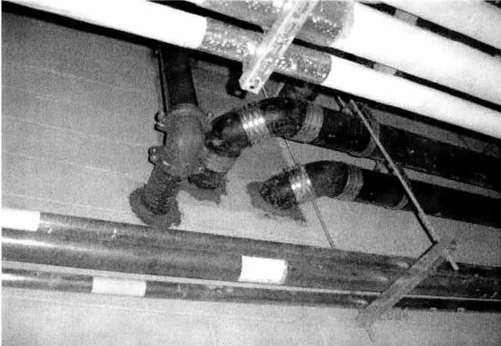
**EN ESTA IMAGEN SE MUESTRA EL TIPO DE SOPORTE CONVENCIONAL TIPO TRAPECIO. A ESTE SOPORTE AUN LE FALTA COLOCAR LAS ABRAZADERAS AISLADAS.**
