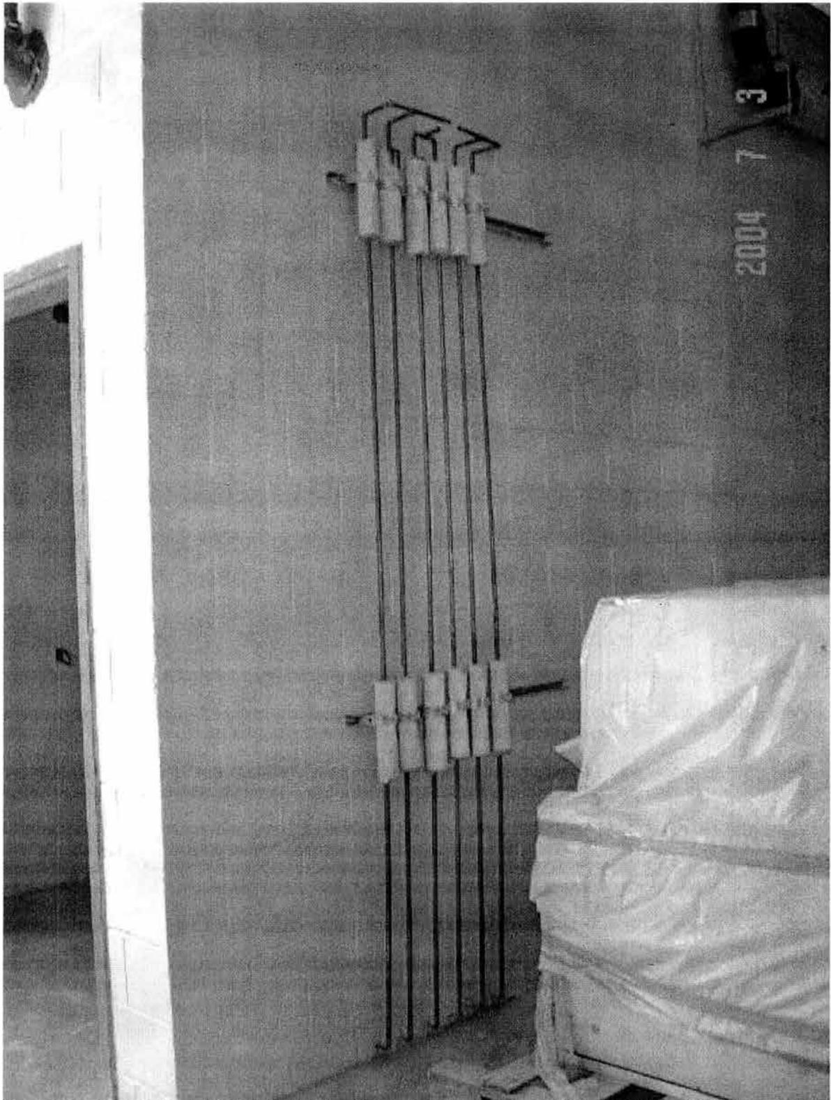
**ESTA FOTOGRAFIA MUESTRA EN LA PARTE SUPERIOR EL LUGAR EN DONDE LLEGARA LA ALIMENTACION DE AGUA POTABLE CON EL USO DE UN "TRAP PRIMER VALVE"**
