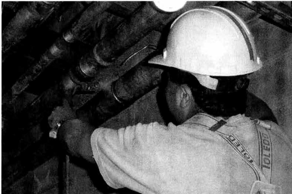
**EN ESTA IMAGEN SE OBSERVA OTRO TRAMO DE LA TUBERIA PREPARADA. SE PUEDE VER EL CALENTAMIENTO DE LA TUBERIA Y EL COPLE Y LA APLICACIÓN DE LA SOLDADURA.**
