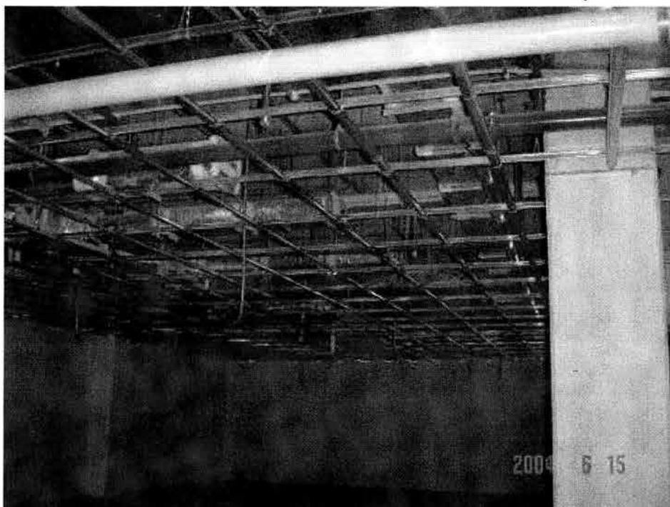
**TUBERIA DE GAS EN AREA DE COCINA. SE OBSERVA QUE LA TUBERIA ESTA COLOCADA VISIBLE DE BAJO DEL PLAFON.**
