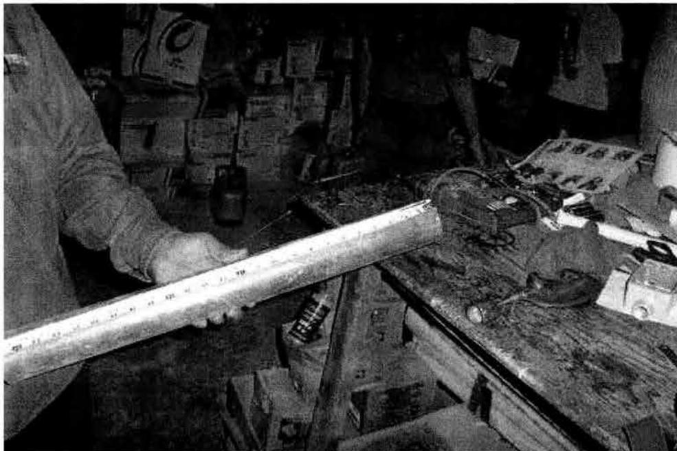
**DIMENSIONAMIENTO Y CORTE DE TUBERIA DE COBRE, SEGÚN EL PROGRAMA DE CORTE.**
