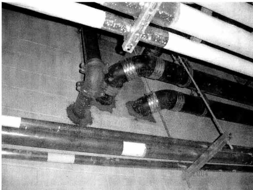
**INSTALACIONES SANITARIAS EN UNA PENETRACION EN UN MURO CONTRA INCENDIO. EL ARO ROJO ES LA APLICACIÓN DEL FIRE STOP SEAL.**
