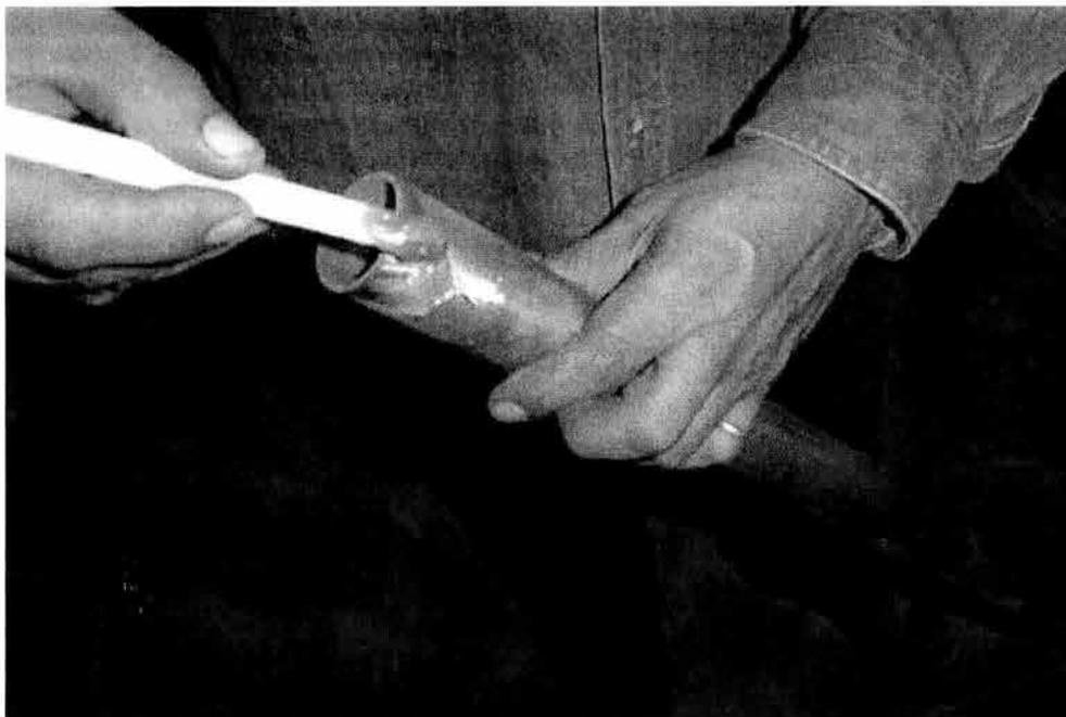
**DESPUES DE LIJADO Y PREPARADO DEL EXTREMO DE LA TUBERIA A SOLDAR, SE COLOCA LA PASTA FUNDENTE.**
