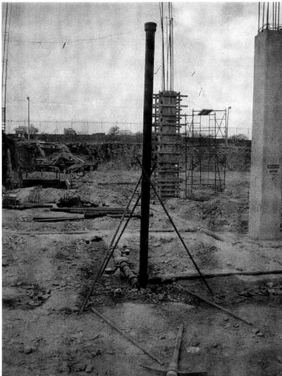
**PRUEBA DE TUBERIA CON UNA COLUMNA DE 3 METROS DE ALTURA A TUBO LLENO, PREVIO AL RELLENO DE LAS INSTALACIONES SUBTERRANEAS.**
