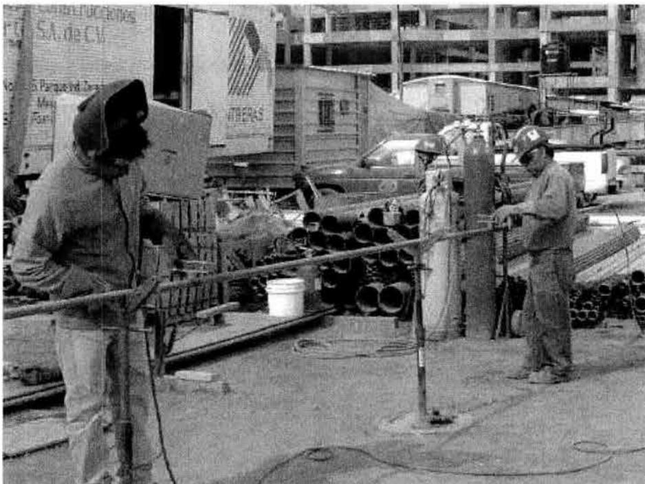
**COLOCACION DE LOS COPLES ROSCADOS PARA SACAR LAS DERIVACIONES DE LOS ROCIADORES. PREVIO A LA SOLDADURA.**
