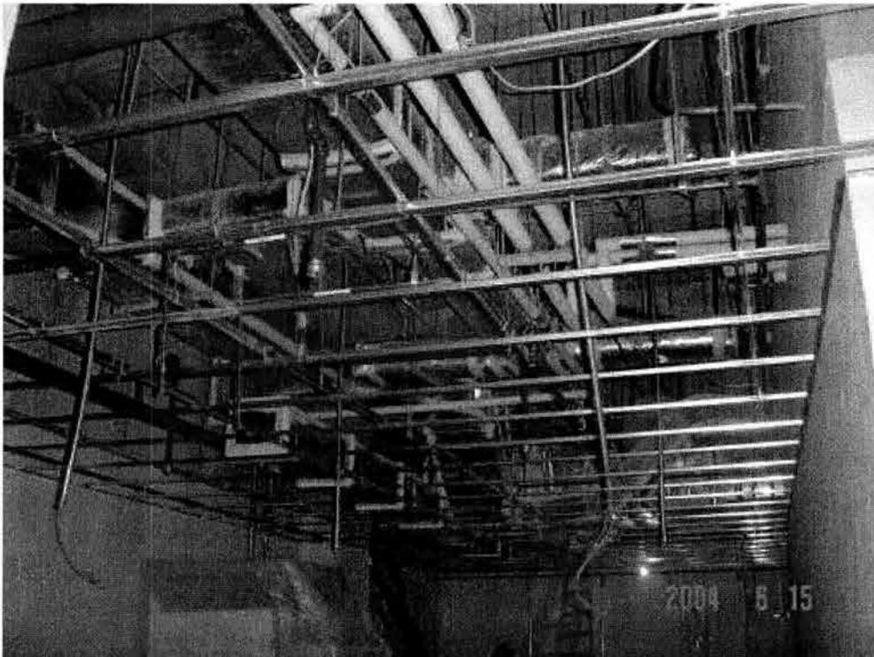
**AREA DE LAVANDERIA, SE PUEDE OBSERVAR YA LA INSTALACION DE LA ESTRUCTURA DEL PLAFON FALSO, Y POR ARRIBA SE PUEDE OBSERVAR EL SISTEMA COMPLETO CON EL ELEMENTADOR PRINCIPAL, LOS RAMALES Y DERIVACIONES A LOS ROCIADORES.**
