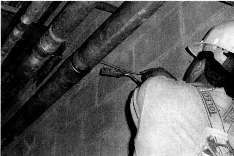
**APLICACIÓN DE CALOR EN LA CONEXIÓN A SOLDAR Y COLOCACION DE LA SOLDADURA DEFINITIVA.**
