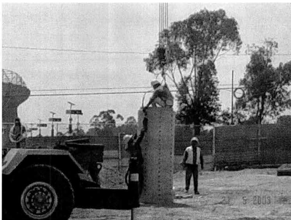
**TUBERÍA PERFORADA QUE ESTARÁ EN LA PARTE INFERIOR DEL POZO DE ABSORCIÓN. SE ESTÁ PREPARANDO PARA SU INCADO.**
