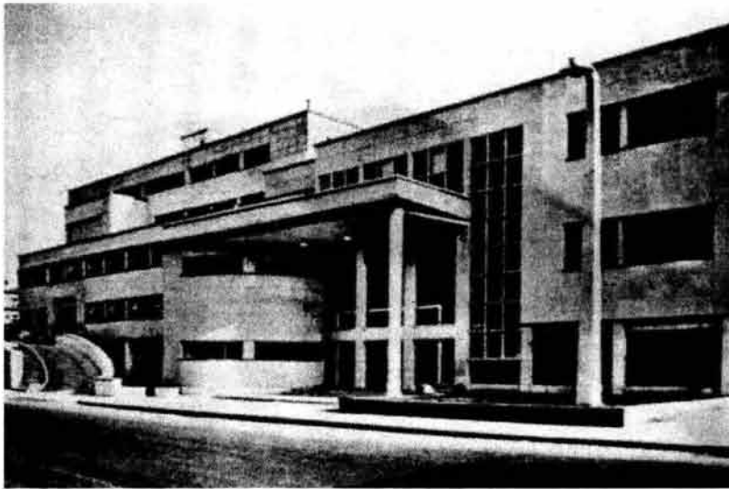
Instituto Nacional de Cardiología, Av. Cuauhtémoc y Felipe Ángeles, México D.F., J. Villagrán García. 1937. El Instituto Nacional de Cardiología es uno de los mejores ejemplos del racionalismo: la función es la que define la forma de este edificio. Las huellas de la escaleras de acceso peatonal, están especialmente diseñadas para que los pacientes al subir las no aceleren el ritmo cardíaco. Fuente: Archivo INBA
