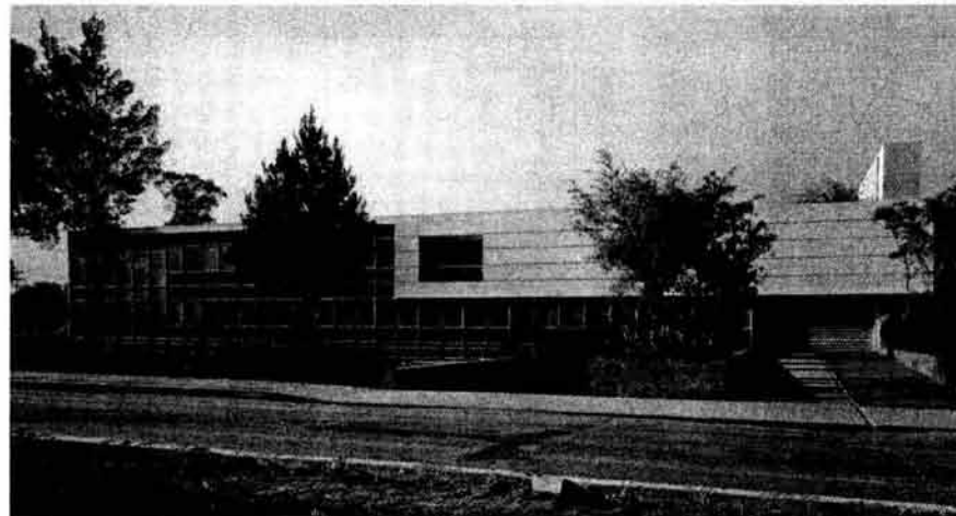
Actualmente esta bien resuelta fachada ha sido torpemente modificada dañando el conjunto en su pureza y funcionalidad. Fuente: Archivo VKZ.
