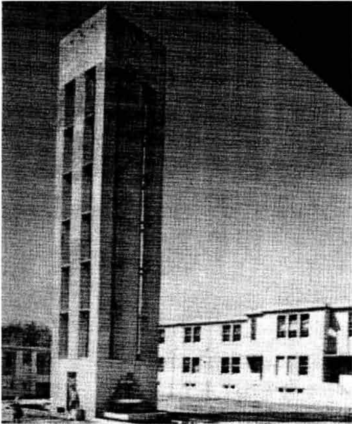
Torre de tinacos, Hospital de Tuberculosos avanzados de Huipulco, José Villagrán García, 1929. Fuente: Archivo INBA.
