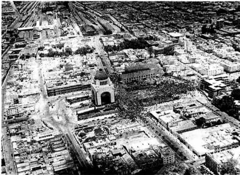
Vista del conjunto urbano del Monumento a la Revolución, 1930-40. AGN, Archivo Fotográfico Díaz, Delgado y García, caja 7122.
