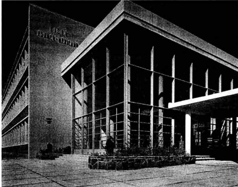
Ingreso principal, el delicado contraste entre el paño macizo de la fachada y la doble altura del vestíbulo principal, en el que se distingue el muro-cortina independiente de la estructura de concreto armado. Fuente: Archivo VKZ.
