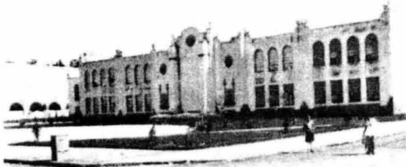
En la Escuela Benito Juárez, Santacilia adopta el esquema de hacienda provinciana: en el centro se encuentra la biblioteca, mientras que dos patios quedan limitados por crujeas que alojan aulas y servicios; se aprecia el refinamiento en los detalles de cantería y ornato en general y la recia comunión de proporciones y escalas. Tonalá y Tlaxcala, México, D.F. 1923-1925. Fuente: Archivo INBA.
