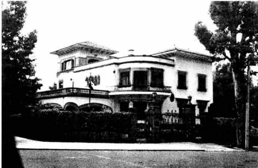
Casa Habitación estilo "Eclectic" Actual embajada del Líbano Foto: RMB, enero 2003.
