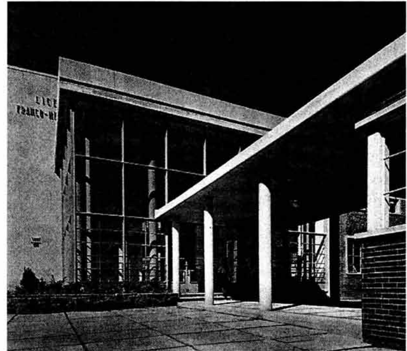
Acceso principal al Liceo Franco-Mexicano, obra del maestro Kaspé en la que el equilibrio de los volúmenes, la utilización de las novedosas técnicas constructivas de la época y la elegancia de los acabados con materiales tradicionales, da como resultado una obra ejemplar del modernismo mexicano.
