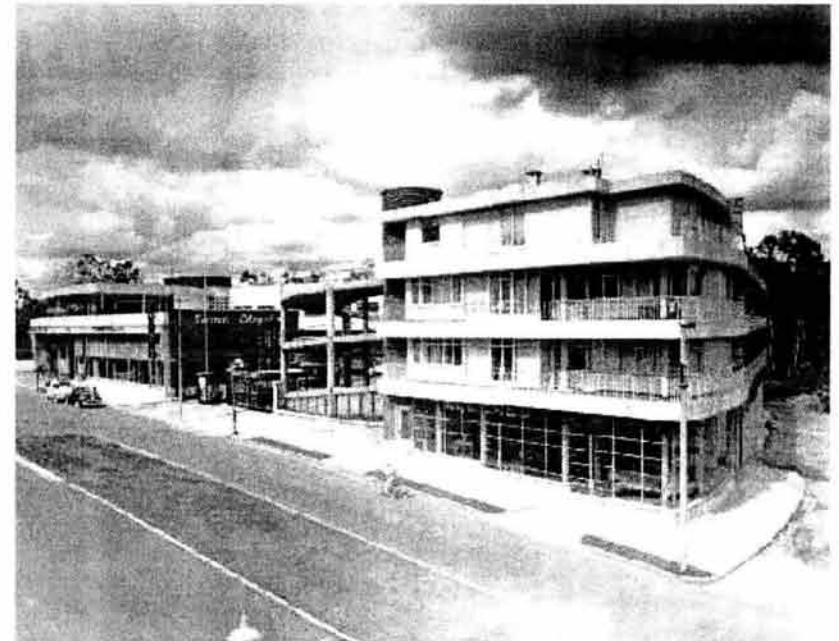
Vista General. En primer plano los apartamentos para el director, el administrador y el velador. Fuente: Archivo VKZ.
