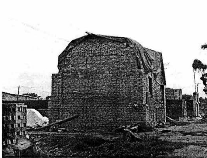
Figura 2.16 Horno cubierto con plástico
