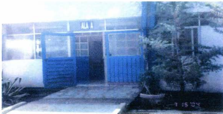
Fotografía No. 14 Entrada Principal de Psicogeriatría del Hospital Psiquiátrico "Dr. Samuel Ramírez Moreno"
