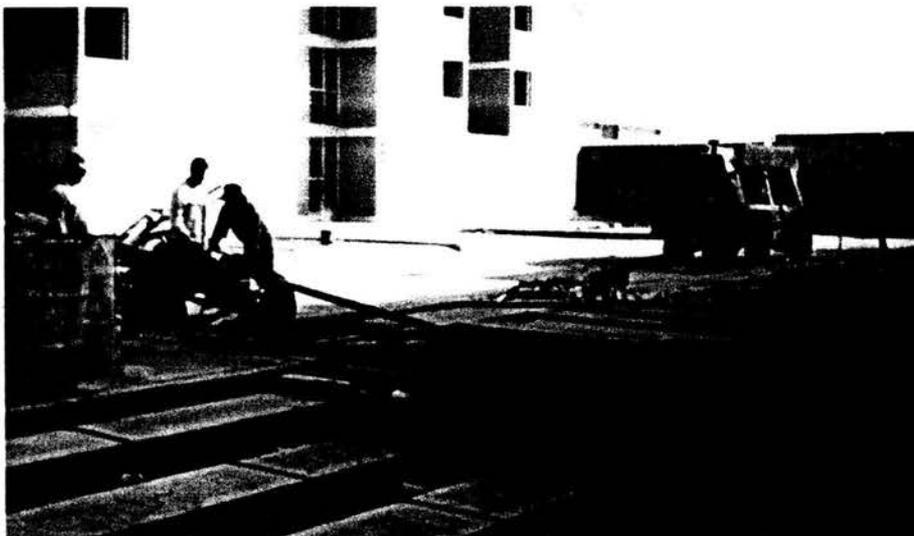
**Fotografía 5.6.** En esta fotografía se observa el equipo con el que se realizó la subexcavación mecánica
