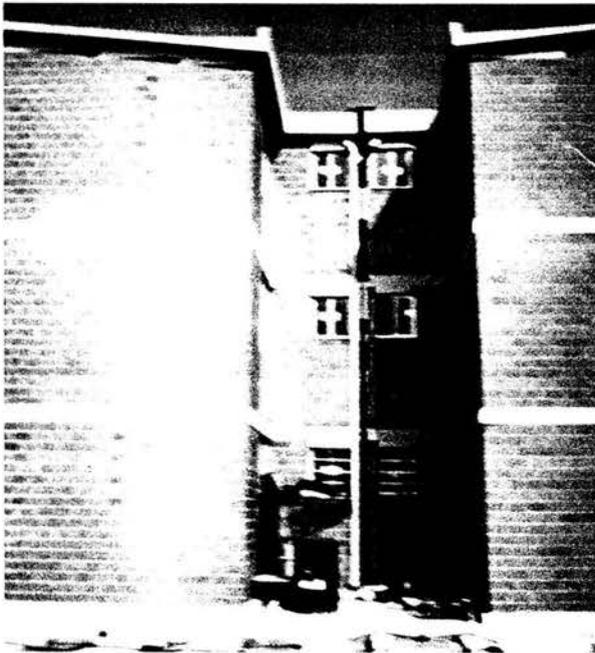
Fotografía 5.1. Se observa uno de los módulos con mayor inclinación (del orden de 5.0 cm) antes de los iniciar los trabajos de subexcavación, obsérvese la separación de la junta constructiva a nivel de azotea
