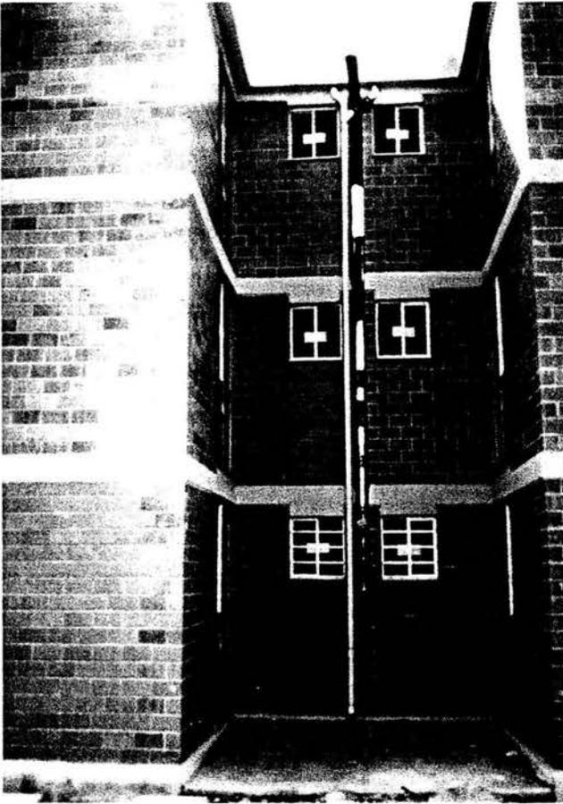
**Fotografía 5.2.** Se observa el edificio de la fotografía anterior después de realizados los trabajos de subexcavación, se aprecia la recuperación de la verticalidad en la separación de la junta constructiva a nivel de azotea
