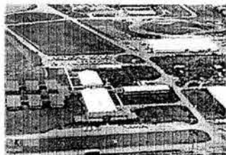
Foto 18 Primeras instalaciones en Sacramento, CA.
