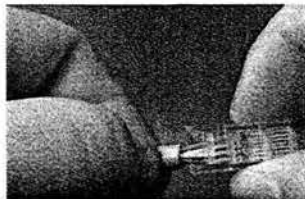
Figura VI.21 Empujar los cables hasta el fondo con la cubierta dentro.
