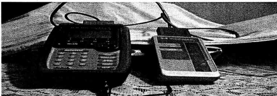
Figura VI.26 Hacer pruebas con cables UTP.
