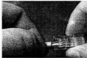
Figura VI.9 Empujar los cables hasta el fondo con la cubierta dentro.
