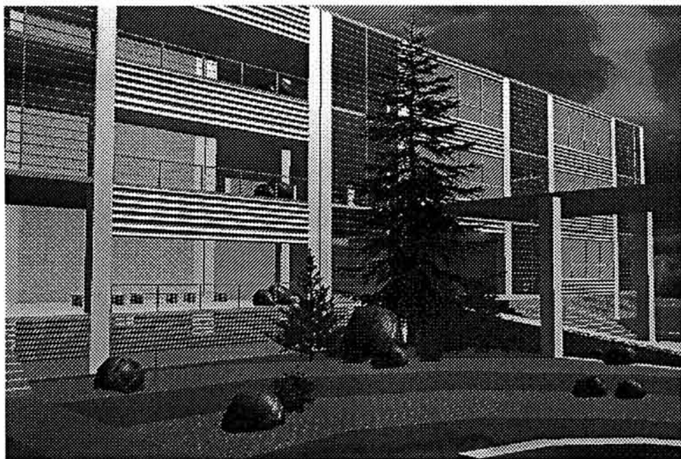
EDIFICIO B. FACHADA SUR
