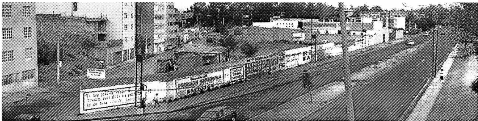
FOTO 2 EN ESTA FOTO SE OBSERVA LA CALZADA DE LA VIRGEN Y LA CALLE BOJORQUEZ
