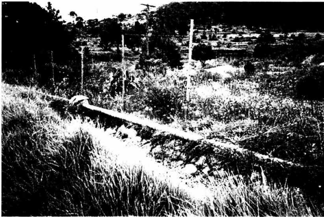
Fotografía 16. Tubo que conduce las aguas de las presas "Jaramillo y "La Estanzuela" a la planta potabilizadora "El Bordo".
