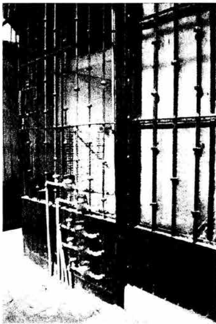
Fotografía 21. Medidores de agua.
