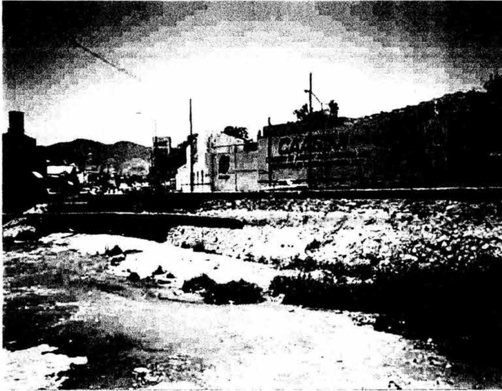
Fotografía 36. Las aguas residuales de la ciudad, se vierten al río de Las Avenidas. En este punto, se integran los efluentes de los colectores 1 y 2.
