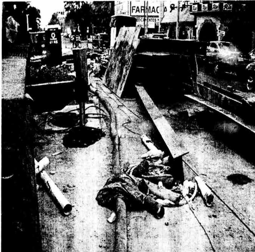
VIGUETAS PARA APUNTALAR LAS PAREDES DE LA CEPA
