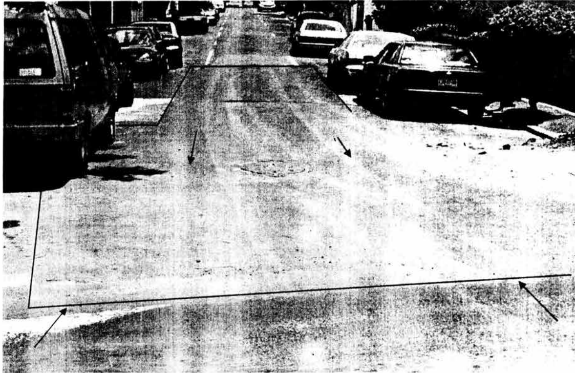
REPOSICIÓN DE PAVIMENTO
