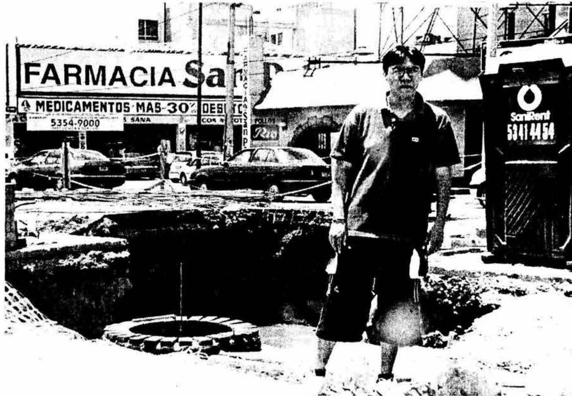
CONSTRUCCIÓN DE COLADERAS
