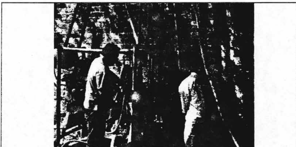
CONTINUACION DEL SONDEO SPT-4 EN EL LADO ORIENTE EN LA PARTE EXTERIOR DEL MUSEO.
