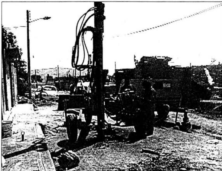
Figura 23.- Proceso de perforación con broca tricónica
