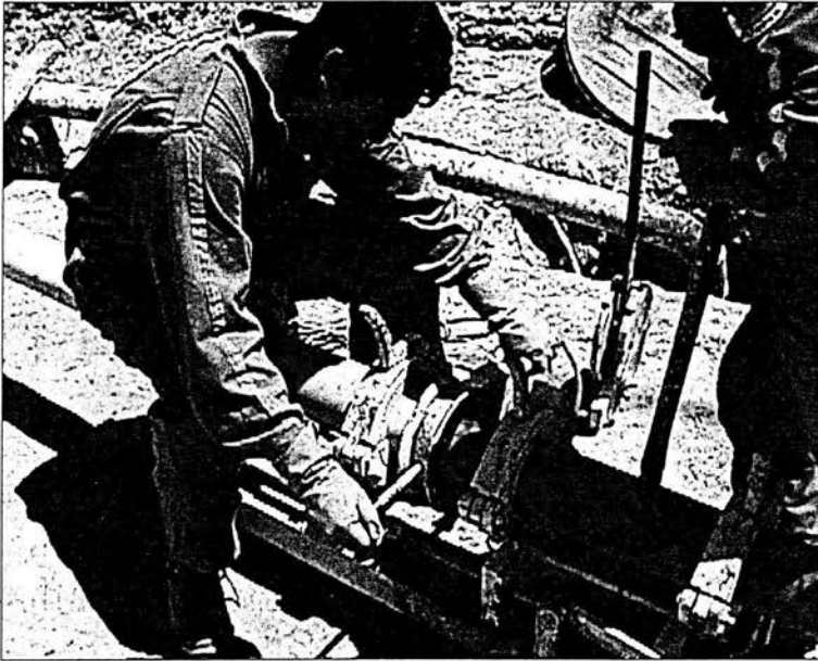
Figura 24.- Soldadura de tubería de polietileno de alta densidad con equipo de termofusión.
