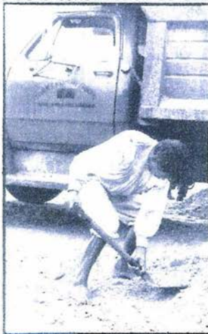
Inicio de la construcción de CEDECO
