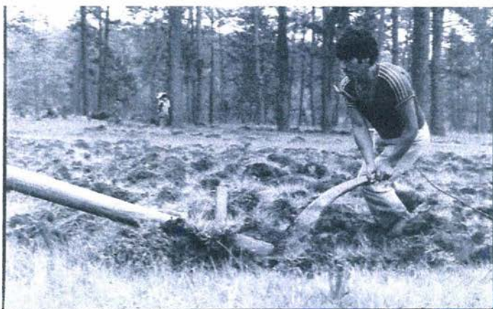
Inicio de la construcción de CEDECO
