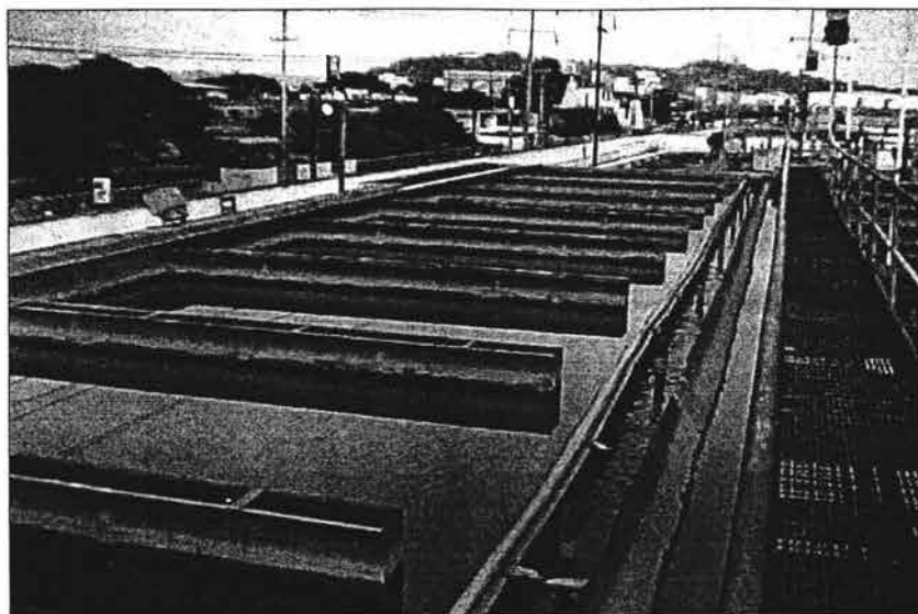
Figura 3.8 Vista superior del clarificador CL-002 B.
