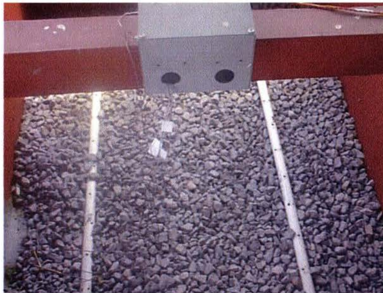
Fotografía 10. Colocación de una cama de grava con grosor aproximado de 15 cm, con el fin de proteger las perforaciones de los tubos, y además ayuda a que los lixiviados que se formen puedan salir libremente.
