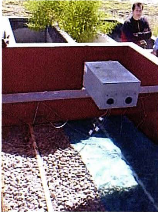
Fotografía 11. El sistema se cubre con una tela de plástico, para mantener a las perforaciones de los tubos libres de posibles obstrucciones.
