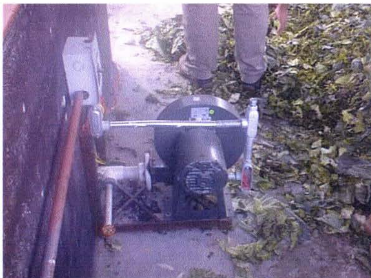
Fotografía 8. Soplador de 400 m 3 /hr, que se conectó con la tubería.
