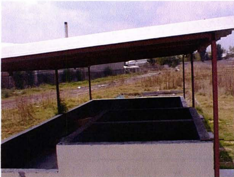
Fotografía 5. Área de experimentación techada, y pozos de muestreo de lixiviados.
