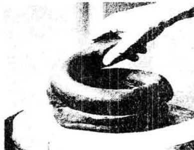
Los rollos gruesos se colocan sobre una base de placa previamente preparada. Fig. 14
