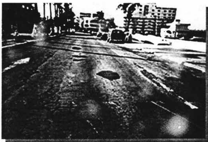
Foto II.3 Huecos y baches abiertos
