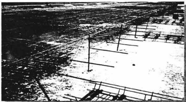
Foto VI. 18 Barras pasajuntas en canastillas de alambón
