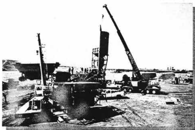
Foto VI. 15 Montaje de Planta de mezclado central
