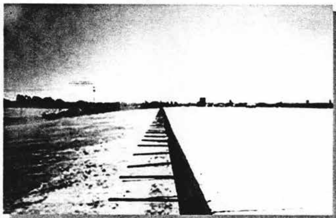
Foto VI. 20 Barras de amarre en junta longitudinal
