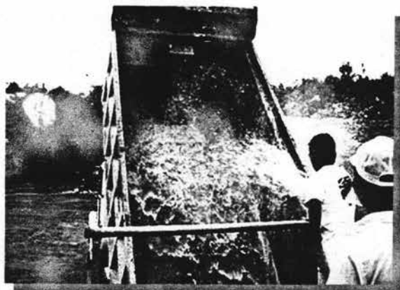
Foto V. 3 Limpieza de caja
