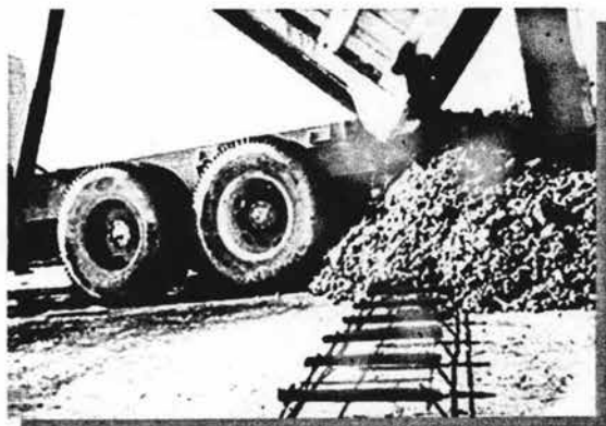
Foto VI. 21 Tendido de concreto
