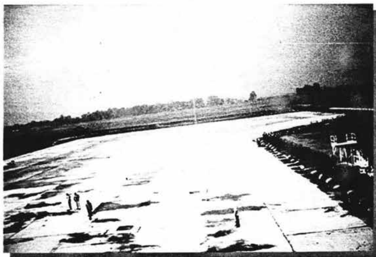
Foto II. 5 Losas de concreto en pista de aeropuerto
