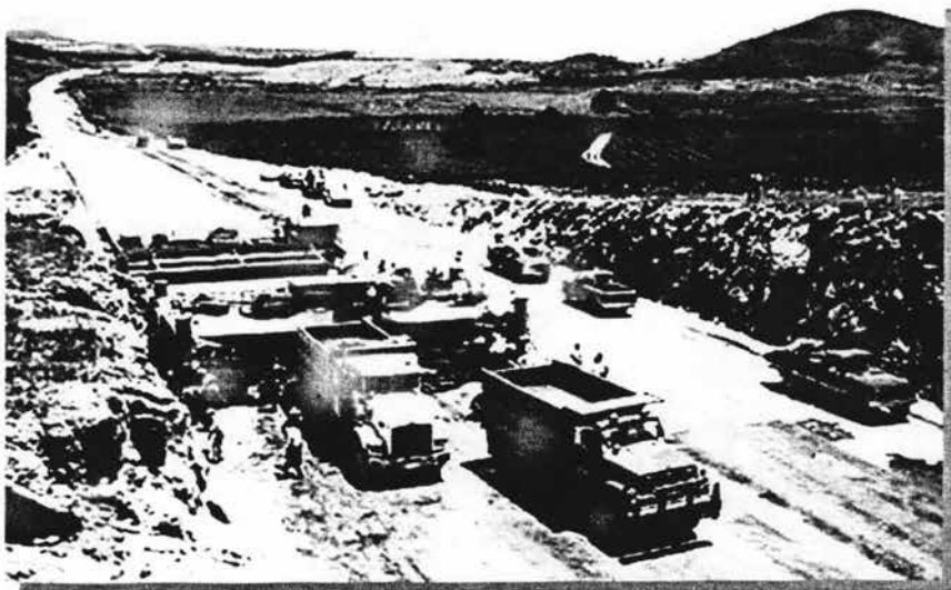
Foto VI. 24 Avance del tren de Pavimentación
