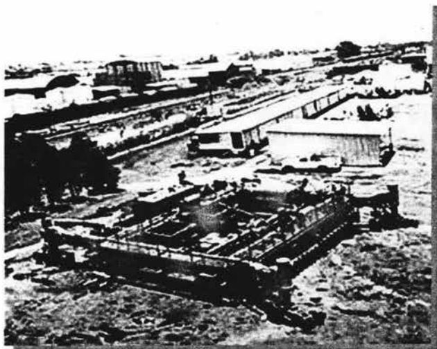
Foto VI. 5 Pavimentadora de cimbra deslizante
