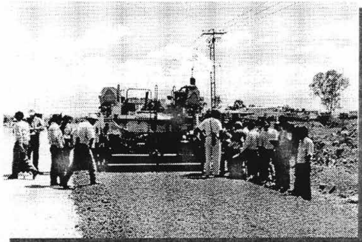
Foto VI. 12 Colocación de base estabilizada Km. 159 Cuerpo derecho
