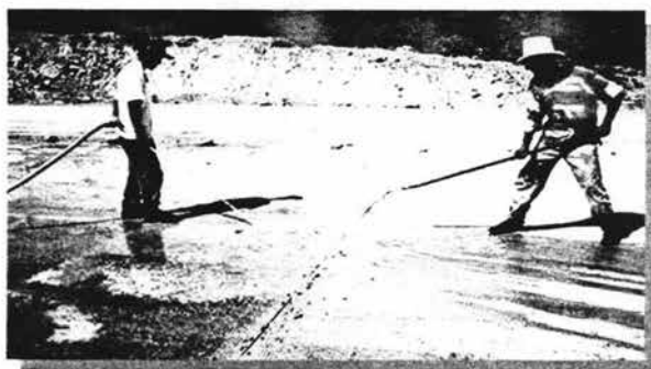
Foto VI. 33 Limpieza con agua a presión
