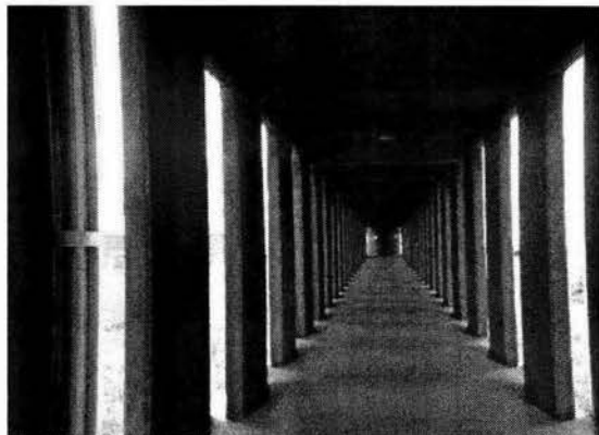
Pasillo de acceso de reos al penal.
