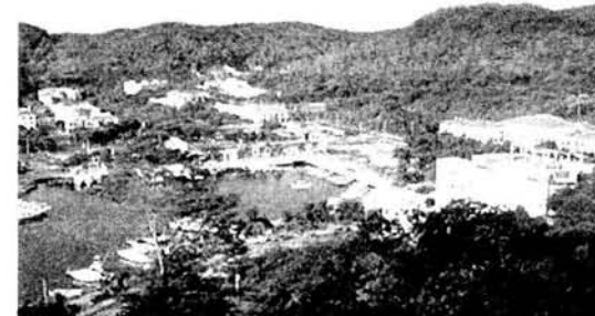
Vista aérea de la marina donde se aprecia la baja densidad de construcción y la gran variedad de recursos ecológicos del sitio. Foto. FONATUR.
