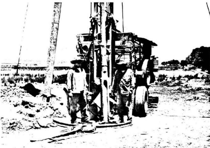
Figura 15: Perforación de pozo TA-17. Uso: Agua potable
