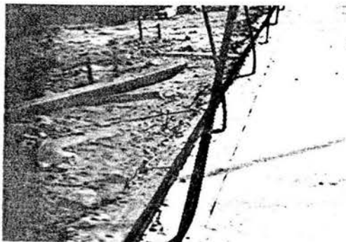
a) Anclajes en losa de cimentación
