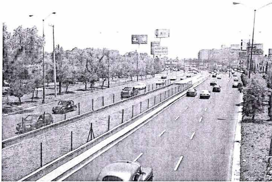
Viaducto Miguel Alemán anteriormente el Río Piedad
