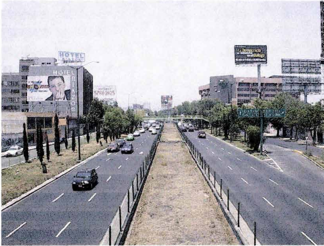
Bordo artificial y vialidad de acceso controlado
