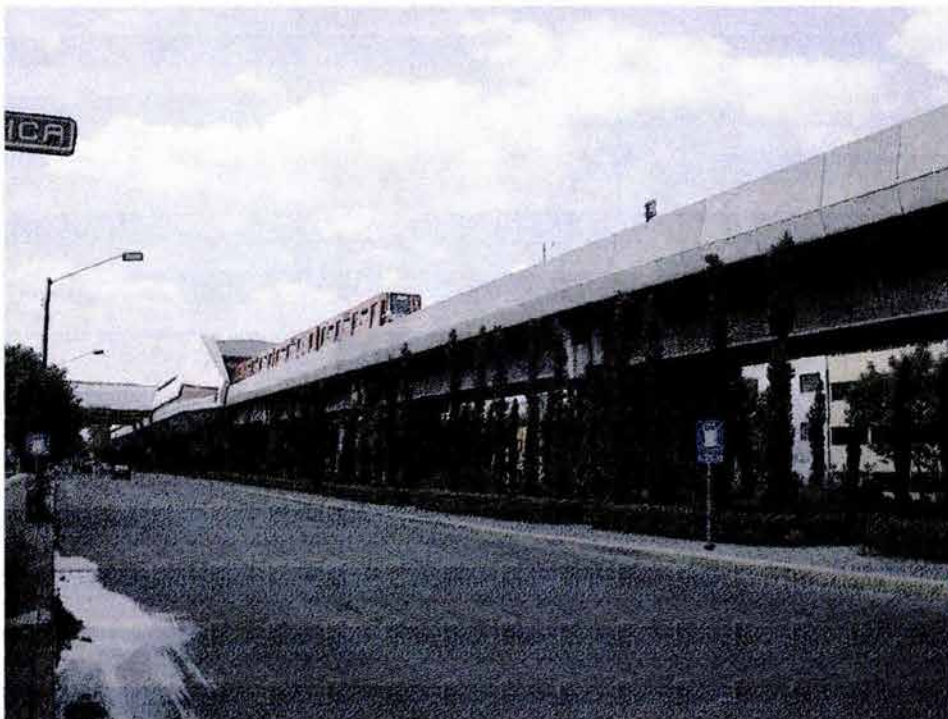
Metro elevado estación Mixihuca
