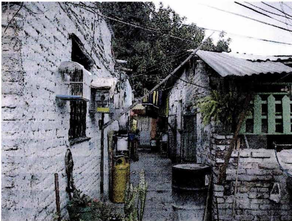
Las viviendas no tienen condiciones de habitabilidad
