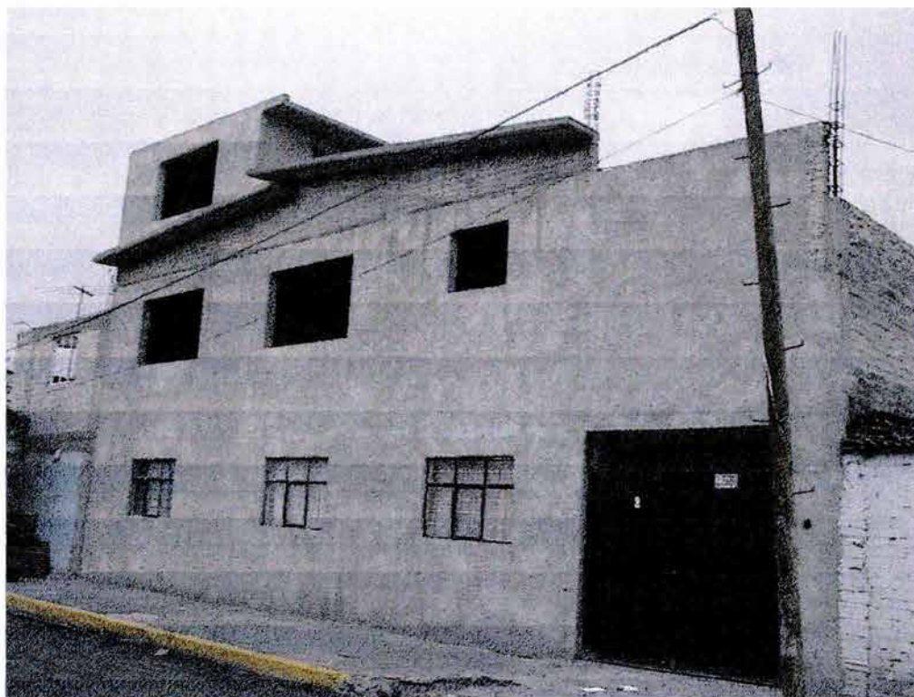
Construcción de vivienda nueva (VNP)
