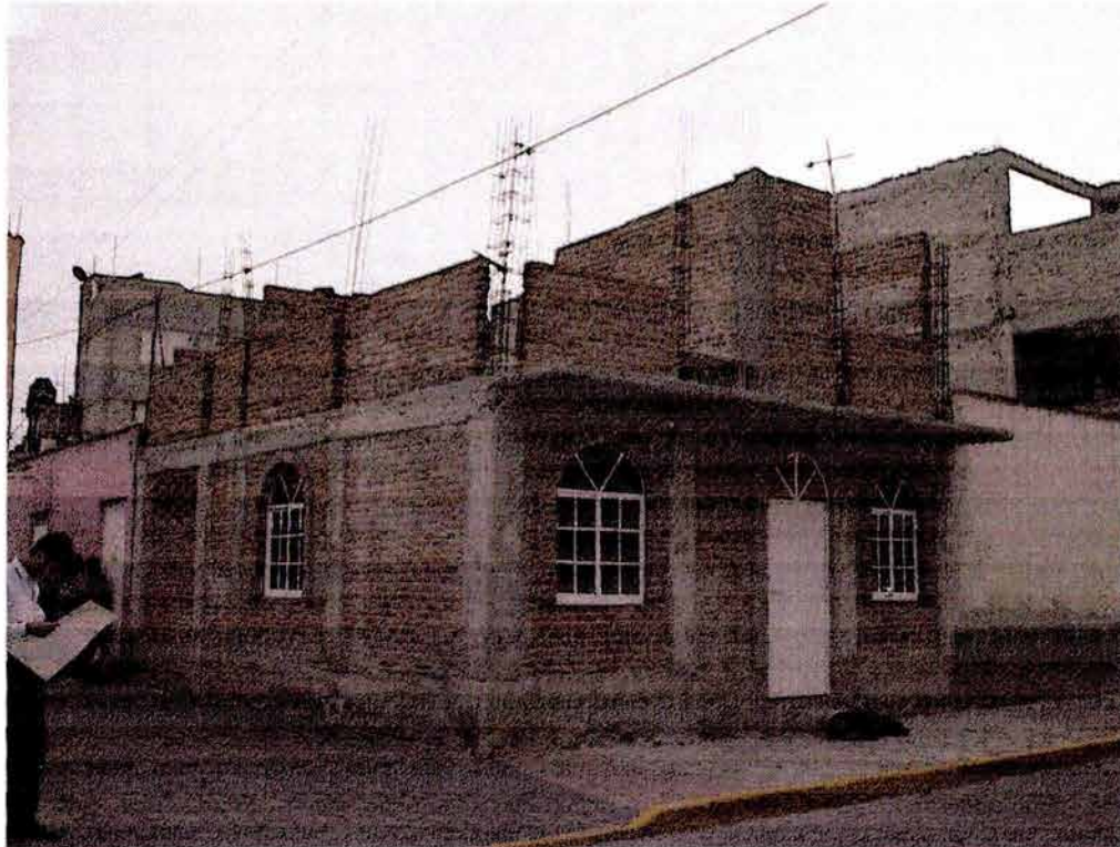
Estado actual de la vivienda
