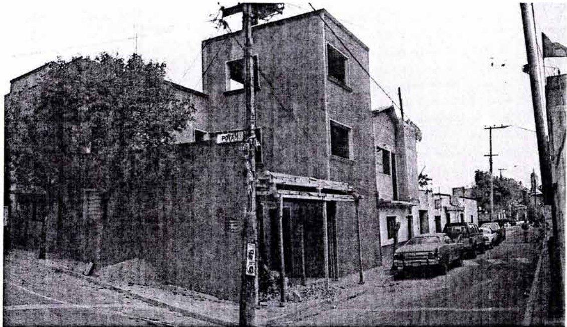
Vista de la construcción en el estado actual
