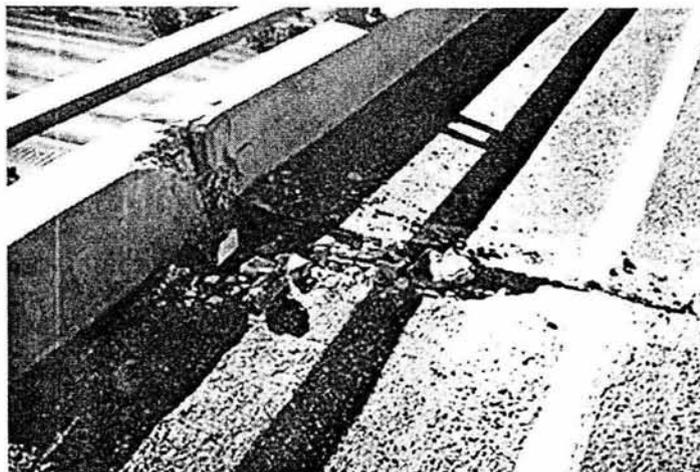
Figura 3. Daño en elementos de superestructura de un puente debido al golpeteo.(EQE)
