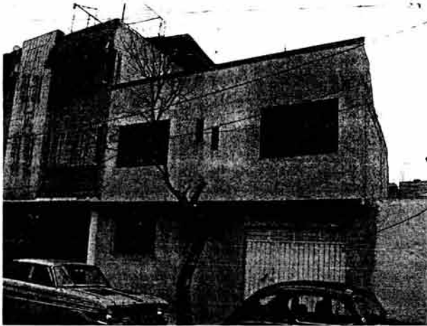
Fachada exterior de la vivienda terminada
