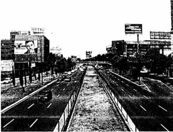
Bordo artificial y vialidad de acceso controlado
