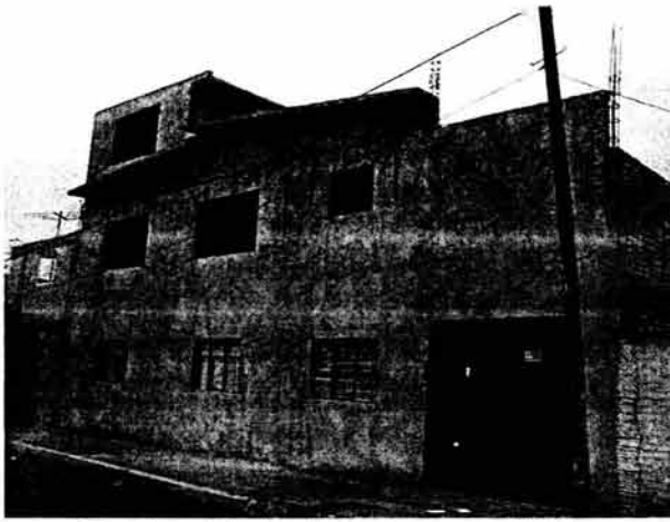
Construcción de vivienda nueva (VNP)
