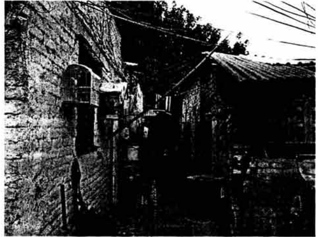
Pasillos en el interior del predio
