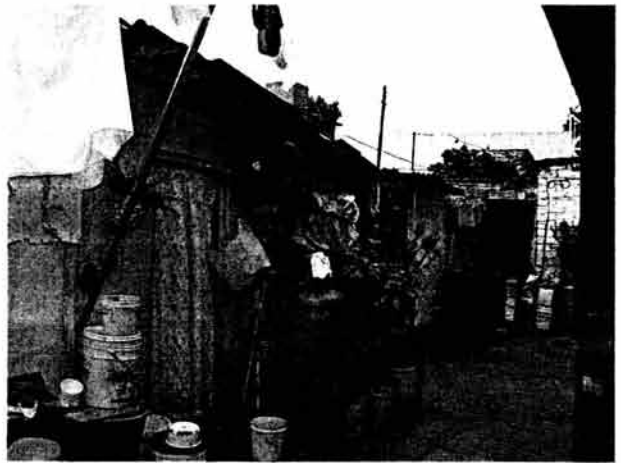
Viviendas construidas con material de desperdicio
