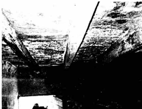
El avanzado estado de deterioro de las viviendas representa un peligro constante para los ocupantes de estas viviendas.
