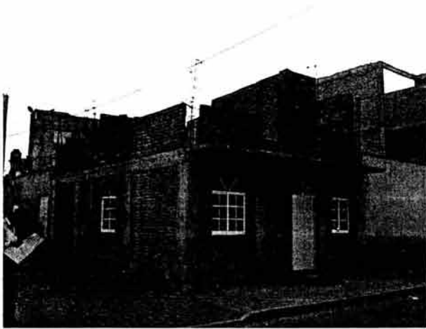
Estado actual de la vivienda
