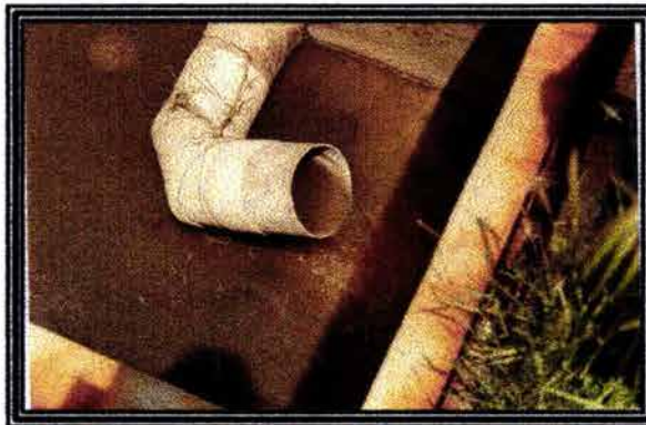
5.- Bombeo de agua a la siguiente cama de hidrófitas
