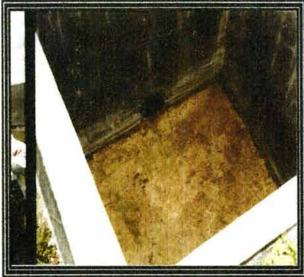
7.- Calidad del agua al final del tratamiento
