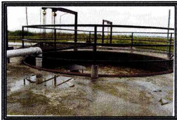
2.- Tanque Sedimentador
