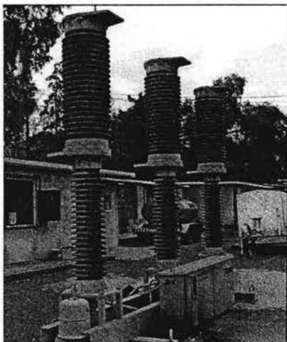
figura 5 Interruptor en SF6, marca SIEMENS accionamiento hidráulico
