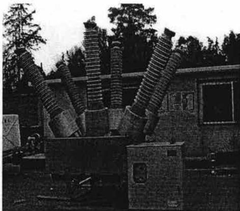
figura 4 Interruptor en SF<sub>6</sub>, marca ALSTOM accionamiento de
