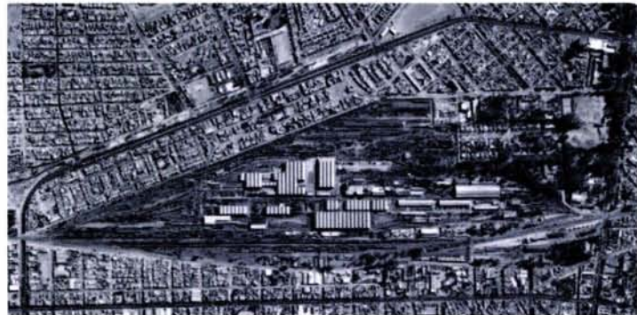
Talleres del ferrocarril en Aguascalientes (foto aérea)
