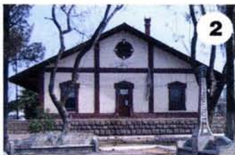
ESTACION DE CARGA: FECHA: PRINCIPIOS DE SIGLO CUBIERTA: INCLINADA MAT: ADOBE APLANADO NIVELES: UNO
