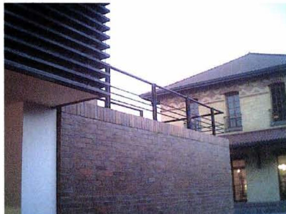
DETALLE DEL "BALCON" Y ESTACION
