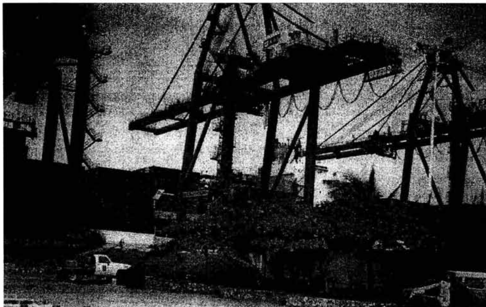
INSTALACIONES TRASERAS DE ICAVE
