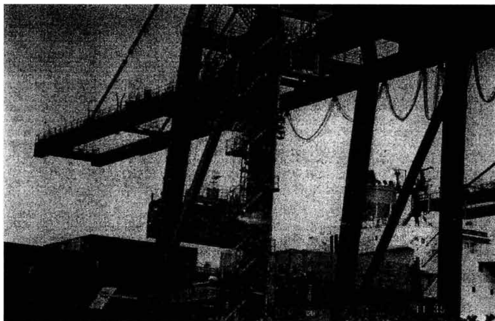
INSTALACIONES TRASERAS DE ICAVE
