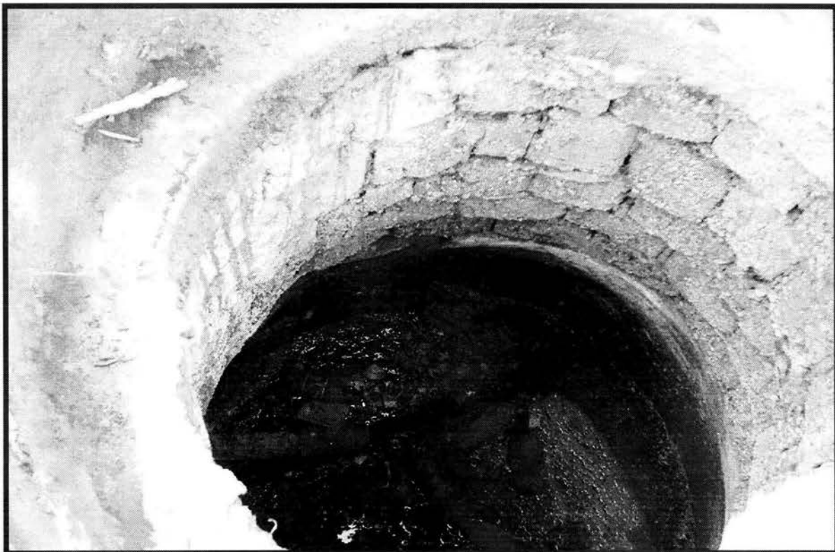
EN ESTA FOTO SE MUESTRA COMO QUEDARON LOS POZOS DE VISITA DE LA RED GENERAL.
