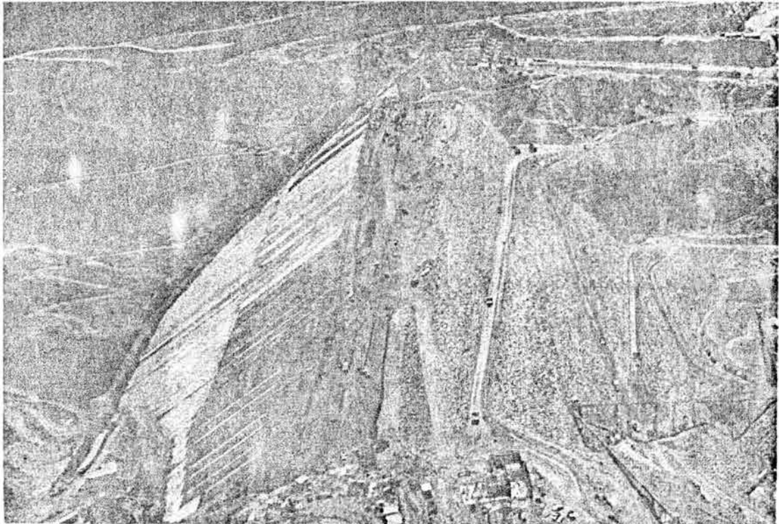
FOTOGRAFÍA IV.4. Cortina de Aguamilpa, mostrando el cambio de color de los dos materiales principales.
