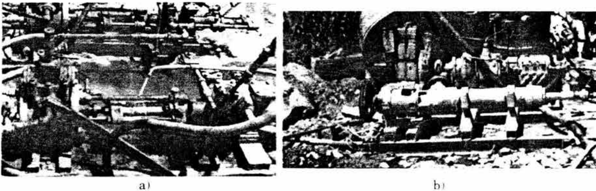
Figura A.2.2 Bombas de inyección: a) tipo pistón; b) de tornillo sinfín
