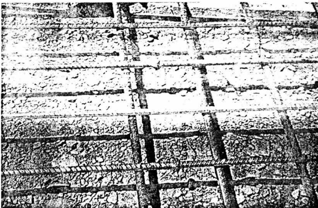
Fotografía III.16 Reforzamiento de la losa - Soldadura
