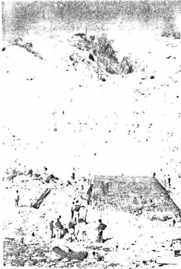
Fotografía IV.9 Excavación y armado del plinto en la margen derecha
