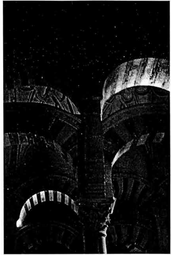
FIG. 16 Córdoba, pantallas de arquerías, s. X
