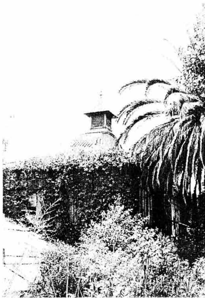
FIG. 2. Cubierta del invernadero Huipulco, construido de hierro y vidrio con remate de aguja para un respiradero, tejuela de lámina de zinc recortada, se aprecian los motivos decorativos de la fachada del mismo, claramente art-nouveau . Fuente: foto de 1970, AFINAH 2067-86
