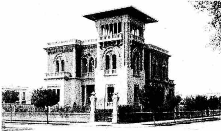
FIG II. Villa con torre mirador de acento morisco, sita en la calle de Orizaba N° 115, hoy demolida. Foto: COLONIA ROMA,
