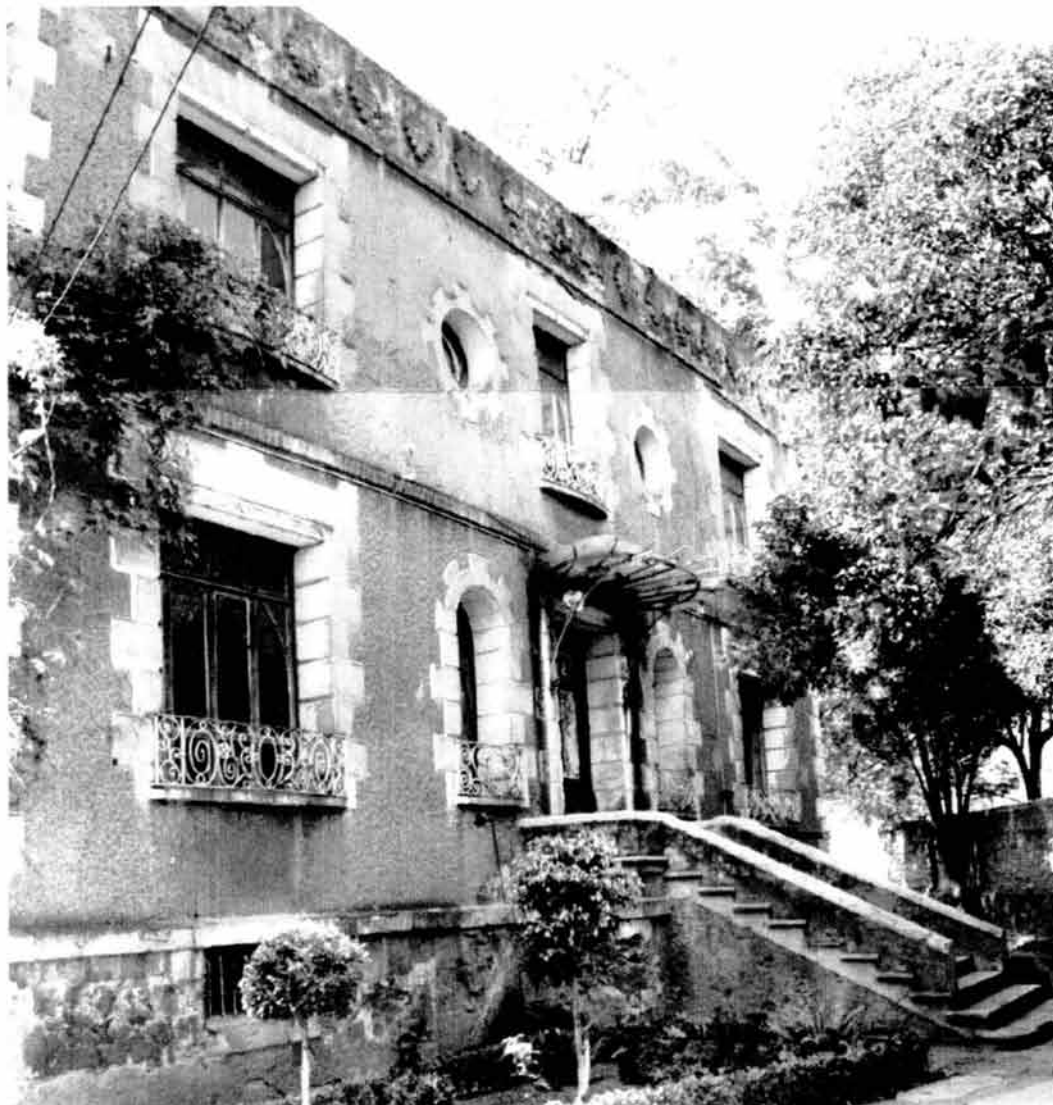
FIG. 10. Fachada principal de la finca "Ville des Roses", localizada en Tlalpan, en el callejón de Apatlaco N° 17, construida en la primera década del siglo XX. Foto: JPazGF, 1997.
