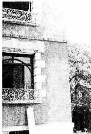
FIG: 63 Aquí muestra la intervención de 1998, se puede ver la fachada sin sus almohadillados de esquina, la pérdida del salpicado y el aplanado nuevo realizado sin regla a la usanza de los aplanados virreinales. Foto: JPazGF, 1998.
