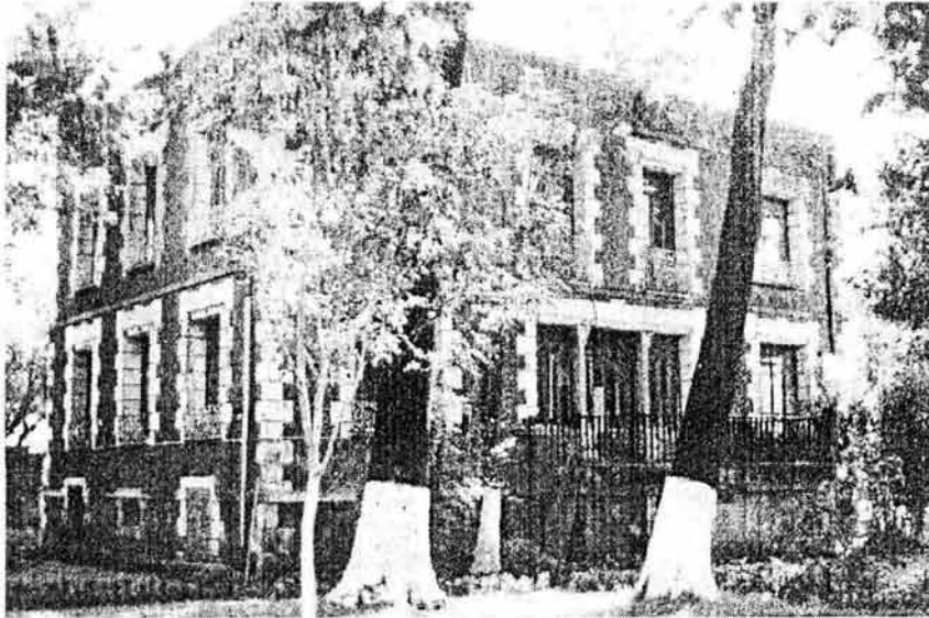
FIG. 11. Vista general de la casa desde el jardín posterior cuya terraza se ve sensiblemente alterada. Se pueden apreciar el aplanado salpicado y los almohadillados de estuco originales. Foto: JPazGF, 1997.
