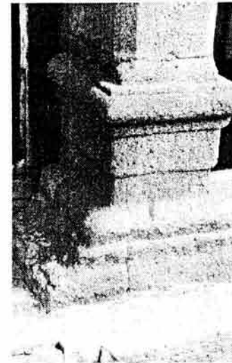
FIG. 19. Detalle de base y pedestal de columna de cuya forma y proporciones no corresponden a un orden clásico definido. Se observa importante desgaste de la cantera gris de la pieza. Foto: JPazGF, 1997.
