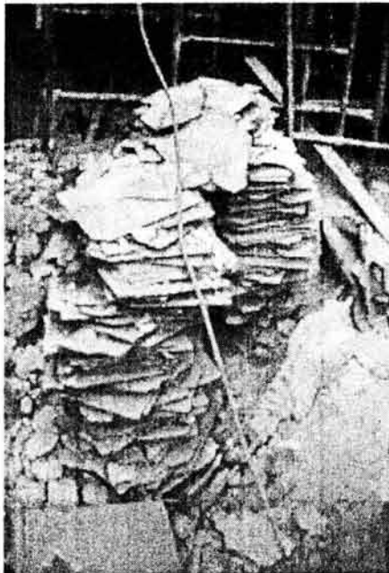
FIG: 59. Al comenzar los trabajos de intervención en el año 1998, se hizo este hallazgo: las tejas de pizarra se encontraban almacenadas bajo la terraza, lo que nos da una confirmación física de la existencia de la mansarda. Foto: JPazGF, 1998.
