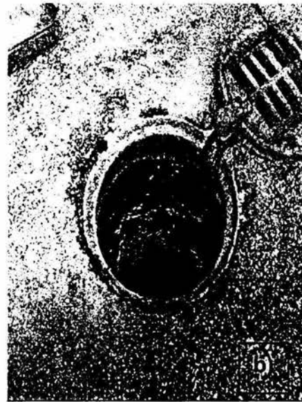
Puntos de muestreo de lodos: a) recirculación de lodos al tanque de aireación y b) purga del sedimentador primario (fotos cortesía de Siglo Ambiental Coyoacán S.A. de C.V.)
