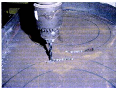
Figura 2.7. Recorte de las bocas del convertidor.
